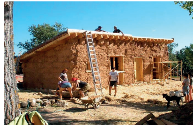
Imagen 9: Personas construyendo con adobe y técnicas tradicionales.
