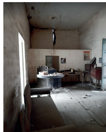
Imagen 18: Cielo raso Casa Francesa. Fuente: Elaboración propia.
