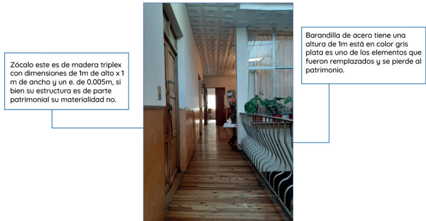
Imagen 90: Pasillo Casa Sarmiento. Fuente: Elaboración propia.
