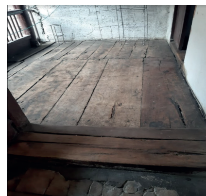
Imagen 16: Piso de madera Casa del Parque.
