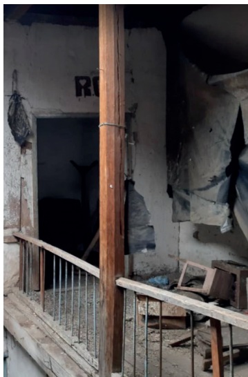
Imagen 20: Balcones Casa Francesa.
