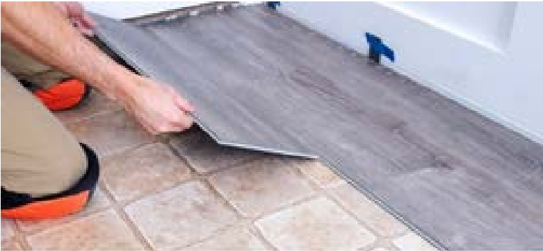
Figura 116. Instalación de pisos vinílicos
