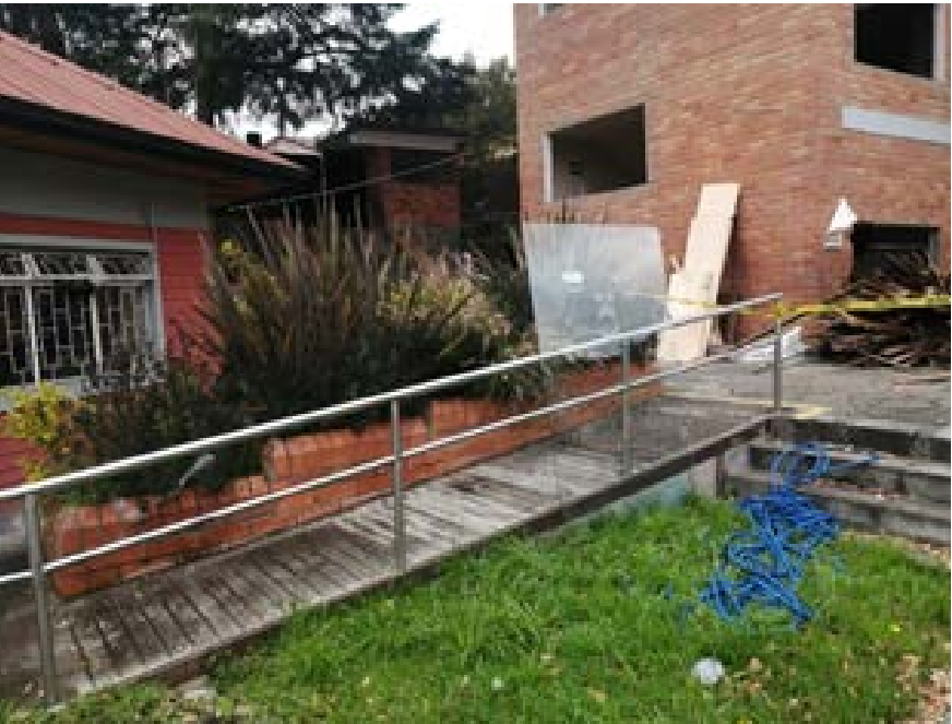
Figura 13. Rampa del exterior
