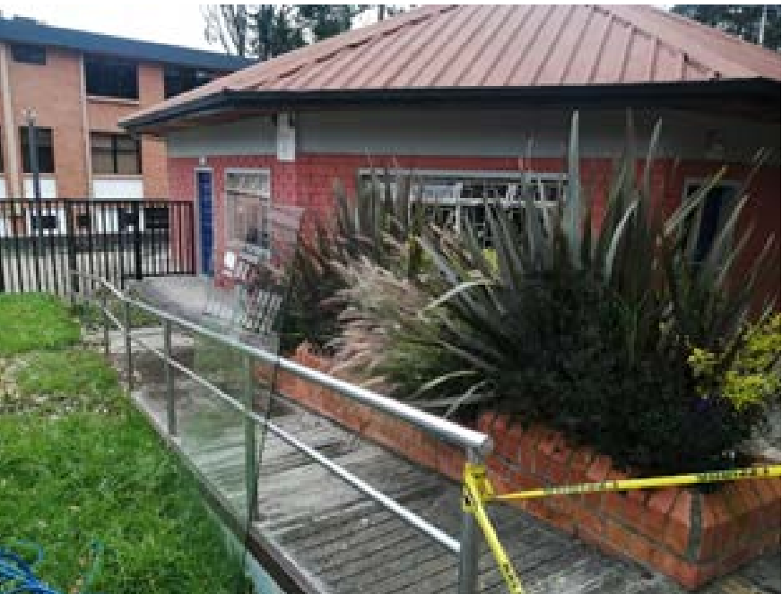
Figura 14. Rampa del exterior
