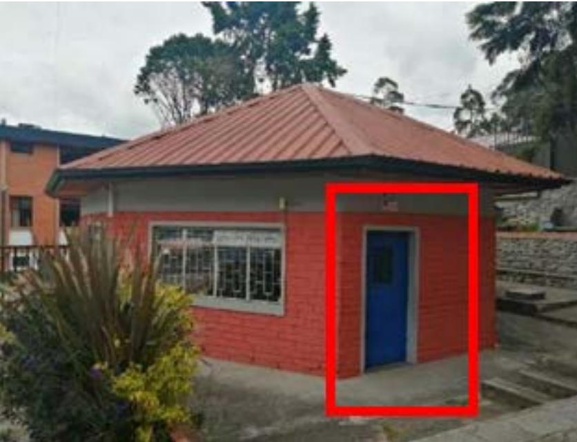
Figura 12. Acceso secundario, en el lateral derecho
