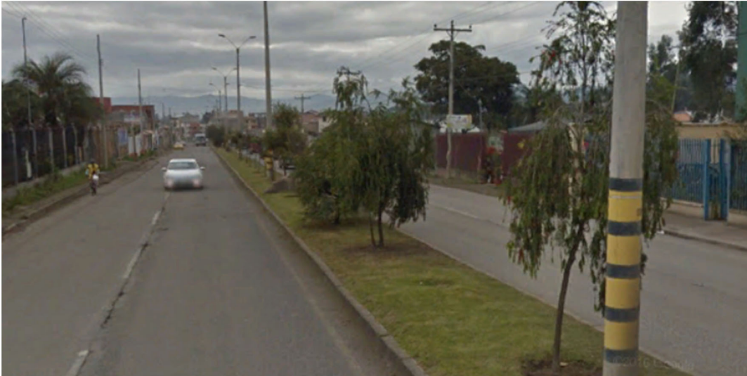
Ilustración 3. 18: Colectora 1, Punto N. 6
