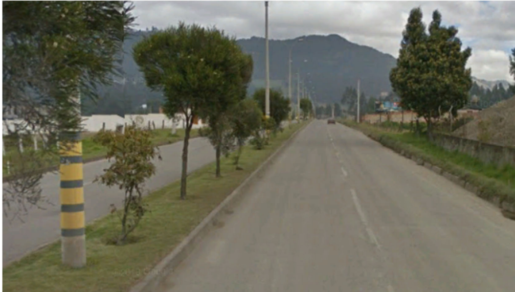
Ilustración 3. 20: Colectora 1, Punto N. 7
