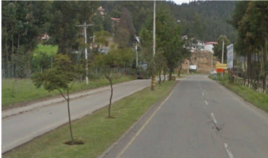
Ilustración 3. 22: Colectora 1, Punto N. 8
