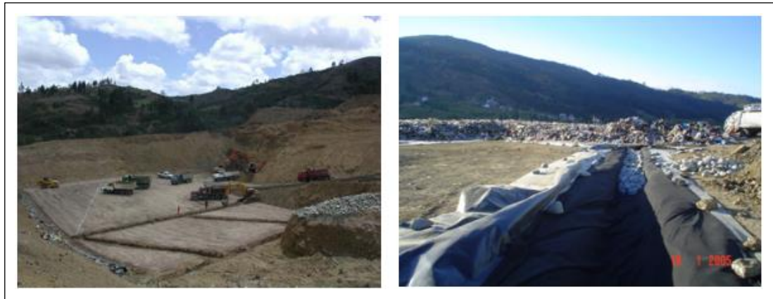
Figura 2.10. Construcción del sistema de drenaje para los lixiviados.
