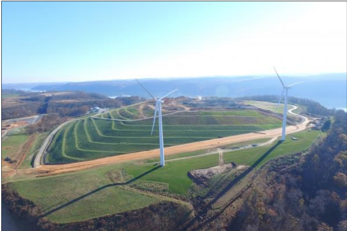
Figura 5.10. Dos generadores eólicos instalados en el relleno sanitario de Frey Farm [Fotografía].
