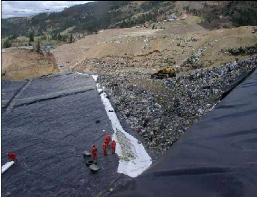
Figura 2.14. Disposición de la basura encima del sellado del suelo de fondo.
