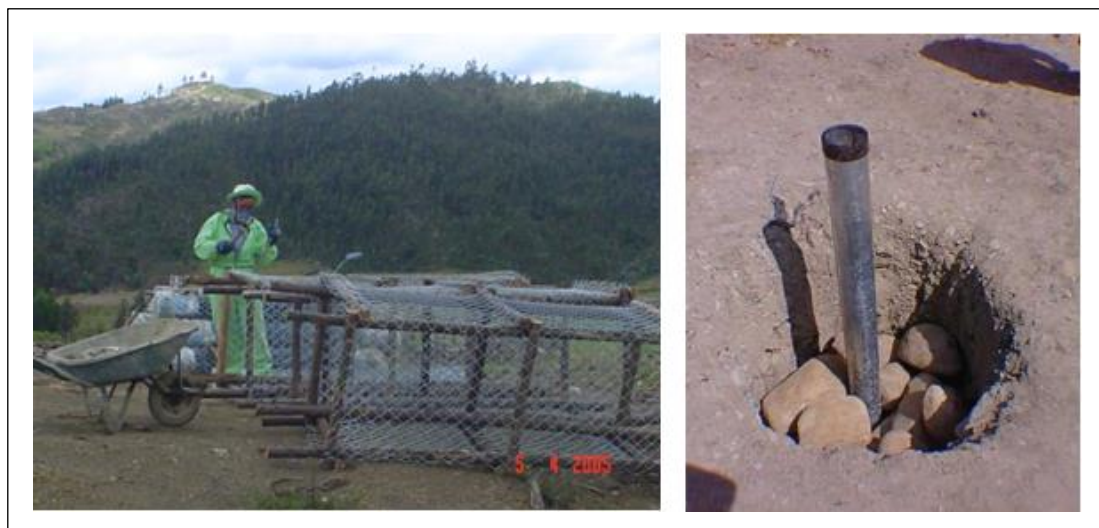
Figura 2.12. Construcción y colocación de la estructura y los ductos de gases.
