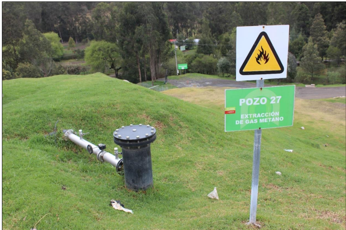
Figura 2.20. Pozo #27 que extrae el gas metano producto de la descomposición de la basura [Fotografía].
