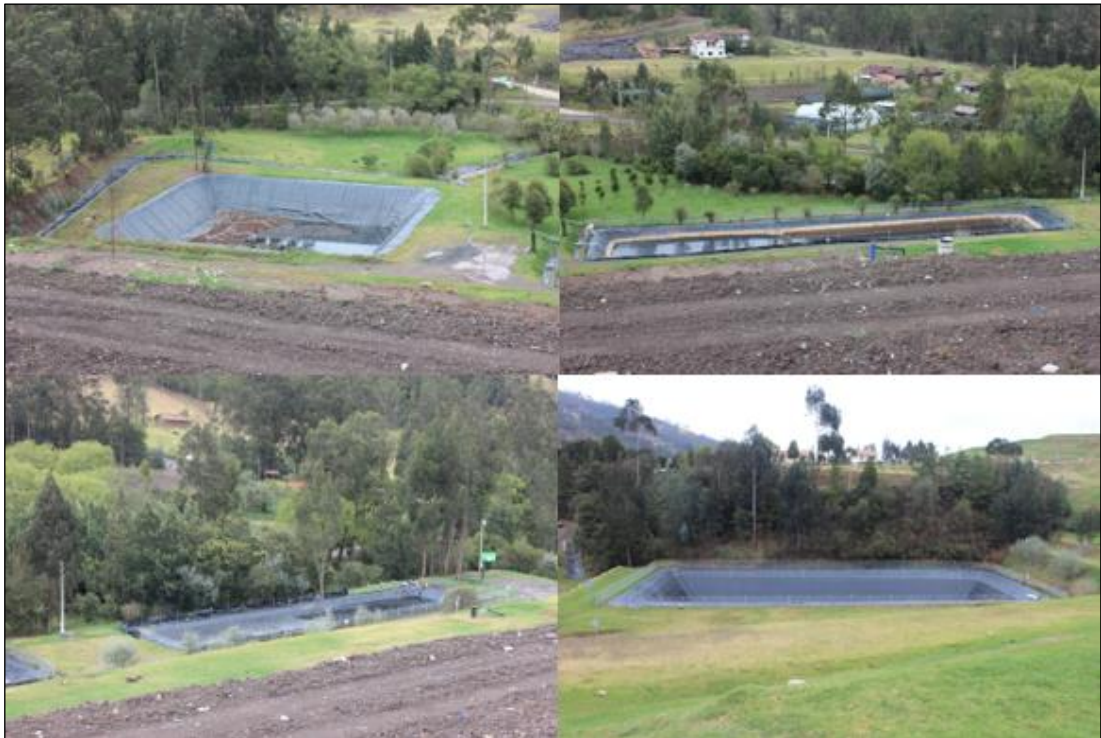
Figura 2.18. Piscinas para la recolección de los lixiviados [Fotografía].
