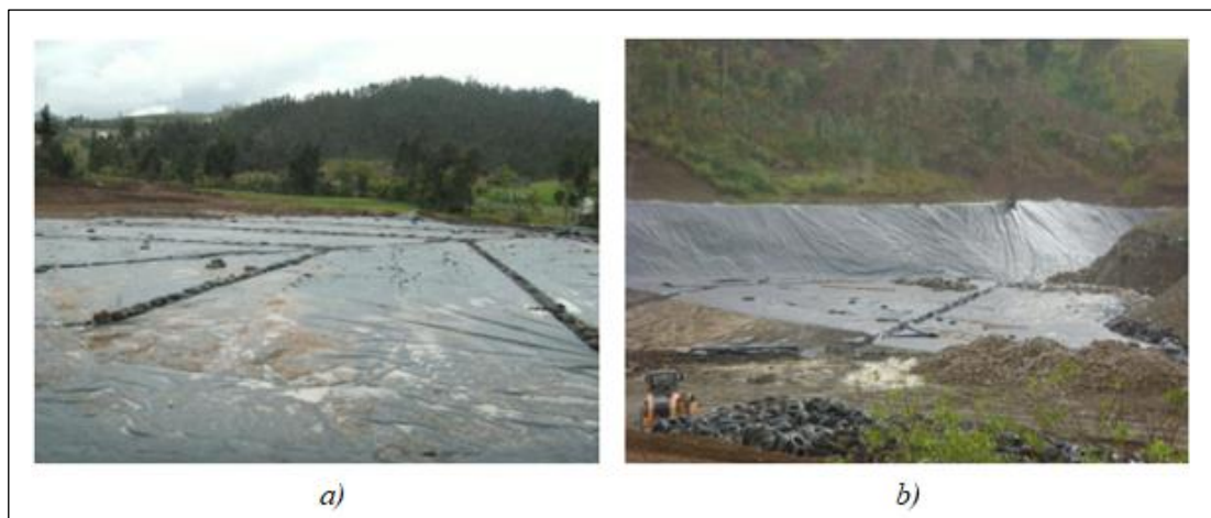
Figura 2.9. Conformación e impermeabilización del suelo de fondo: (a) geomembrana de polietileno; (b) utilización de neumáticos.
