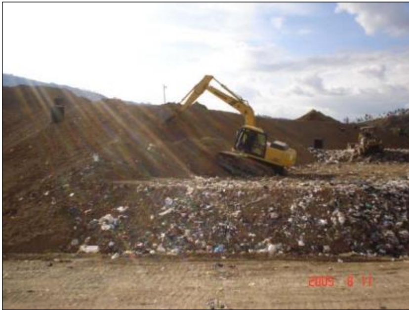
Figura 2.16. Cierre de una terraza del relleno sanitario.
