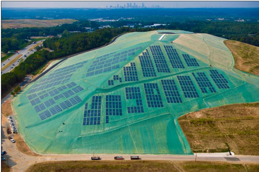
Figura 5.11. Utilización de paneles solares en el relleno sanitario de Hickory Ridge [Fotografía].
