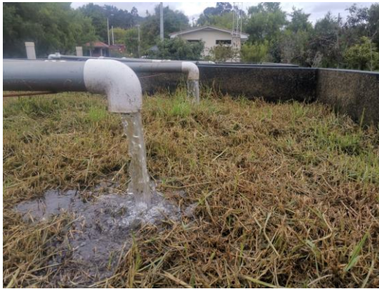
Figura 20 Punto de caída del afluente Fuente: Autor propio
