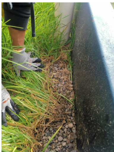
Figura 23: Presencia de zonas muertas en las esquinas del humedal 2 Fuente: Autor propio
