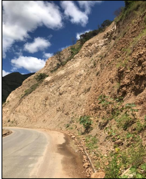
Figura 2.3. Talud vial sector La Era-San Bernabé.
