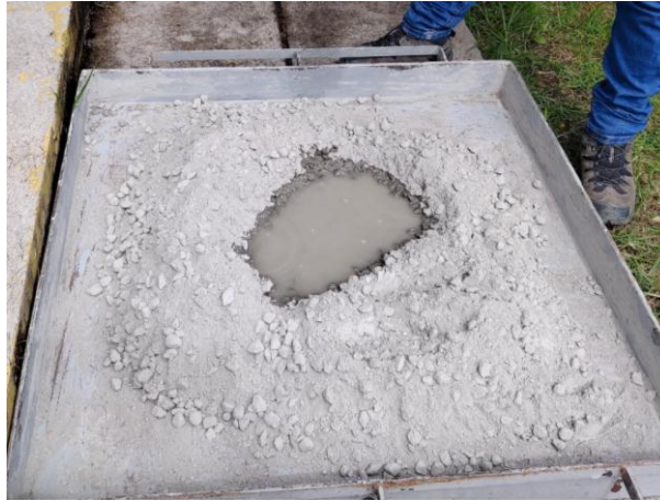
Figura 3.9: Agregado de agua a la mezcla.
