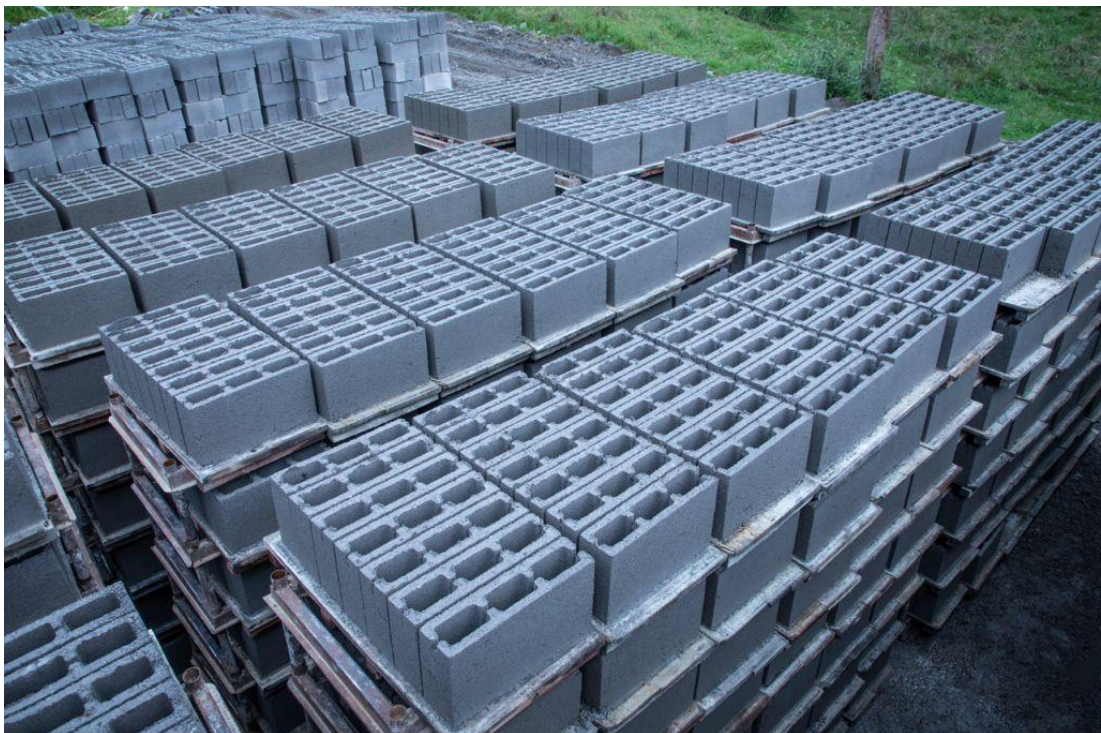
Figura 25. Castillos de bloques a la intemperie
