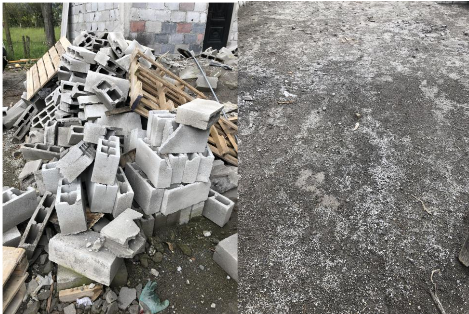
Figura 14. Bloques rotos usados para dar mantenimiento a la calle
