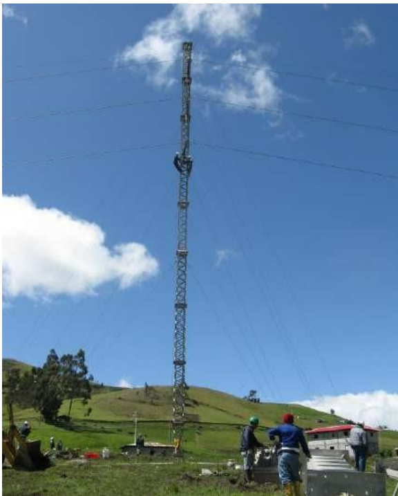
Imagen 5: Trabajo de campo Fuente: Electricom (Castro,2021)
