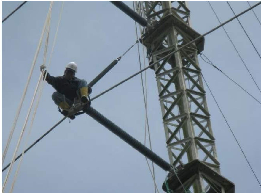
Imagen 7: Trabajo de campo Fuente: Electricom (Castro,2021)
