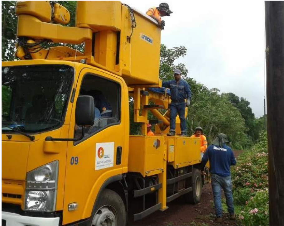
Imagen 9: Trabajo de campo Fuente: Electricom (Castro,2021)
