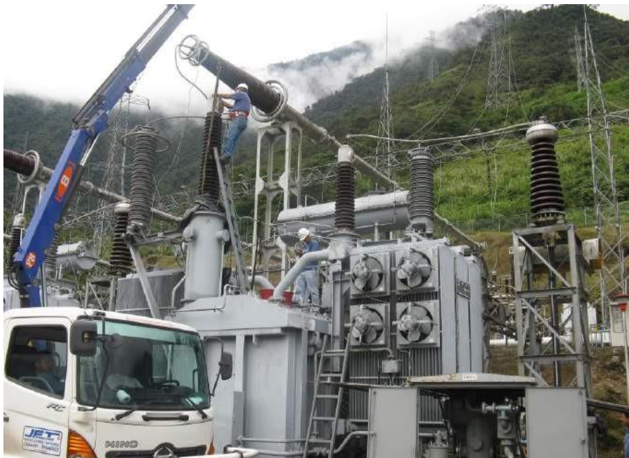
Imagen 8: Trabajo de campo Fuente: Electricom (Castro,2021)
