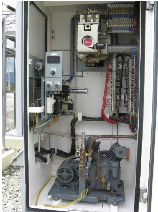
Imagen 6: Trabajo de campo Fuente: Electricom (Castro,2021)
