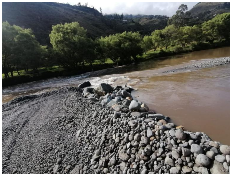
Figura 2.13 Extracción mediante diques transversales.
