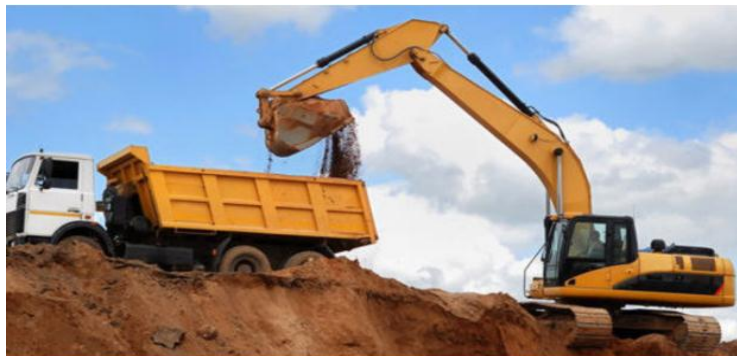
Figura 2.8 Transporte de material de la zona de extracción.
