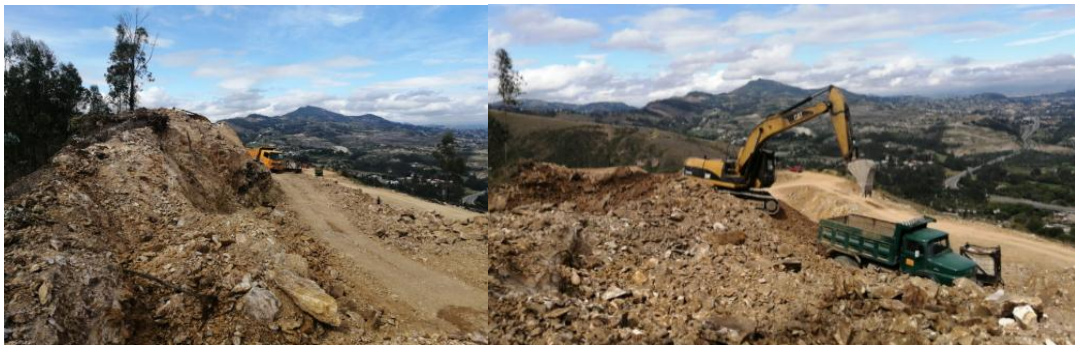
Figura 3.3 Frente de trabajo de la concesión minera "C".
