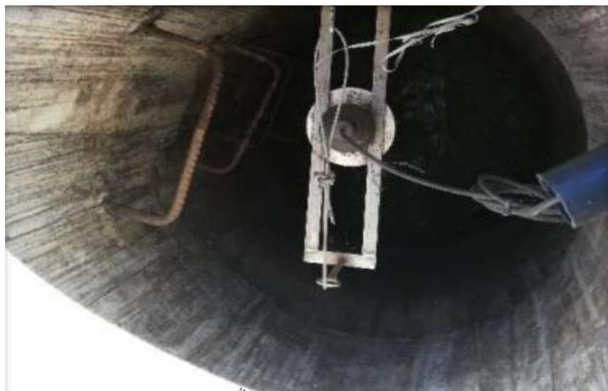
Figura 1. 2 Sensor instalado en pozo de revisión.
