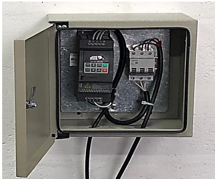
Figura 2.8 Instalación del variador de frecuencia al molino SAG.
