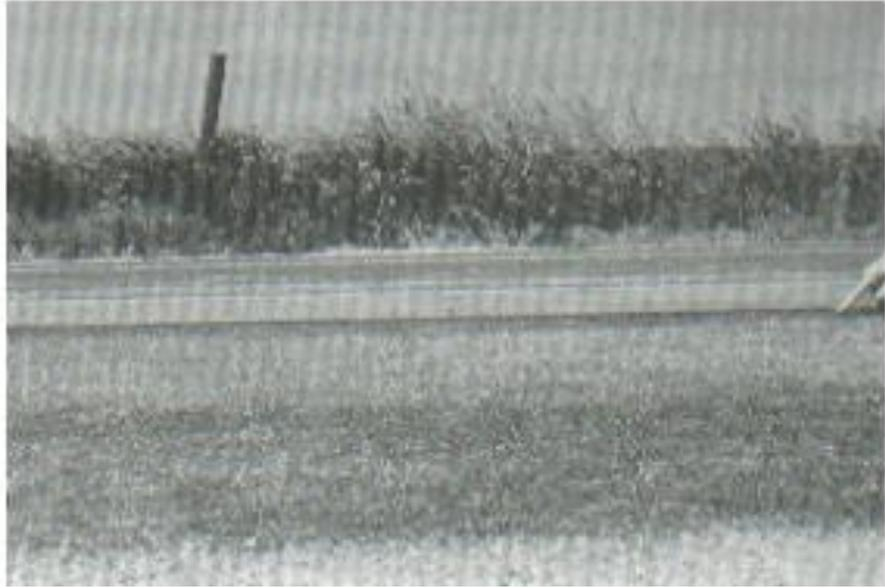
Ilustración 2 - 17: Corrugación de baja severidad
