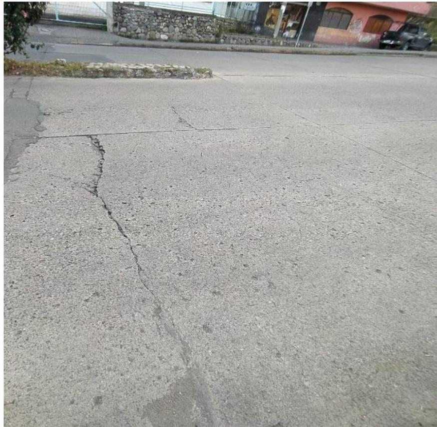
Ilustración 2 - 5: Grieta lineal de mediana severidad, Fuente: Autor
