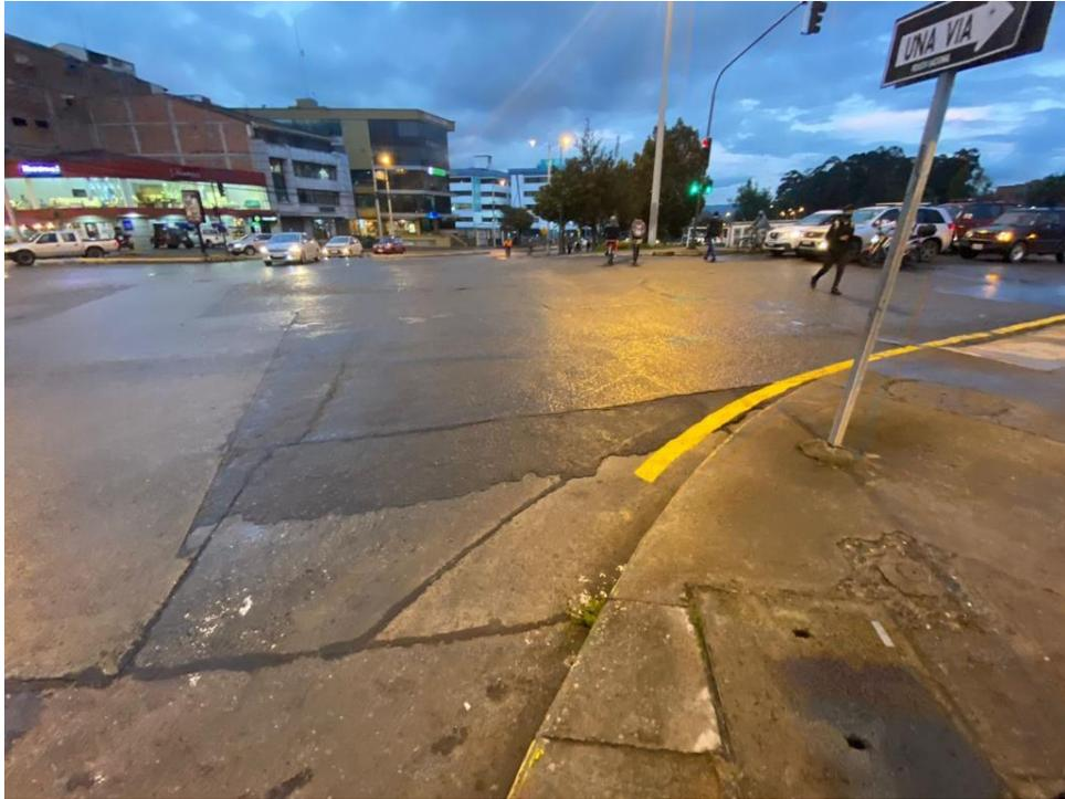
Ilustración 2 - 20: Grieta de reflexión de junta de baja severidad, Fuente: Autor
