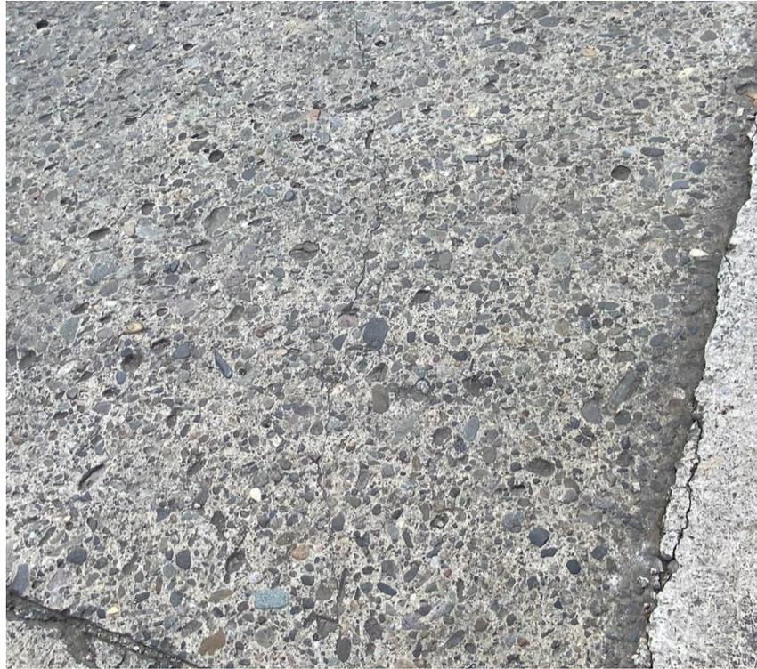
Ilustración 2 - 7: Pulimento de agregados, Fuente: Autor
