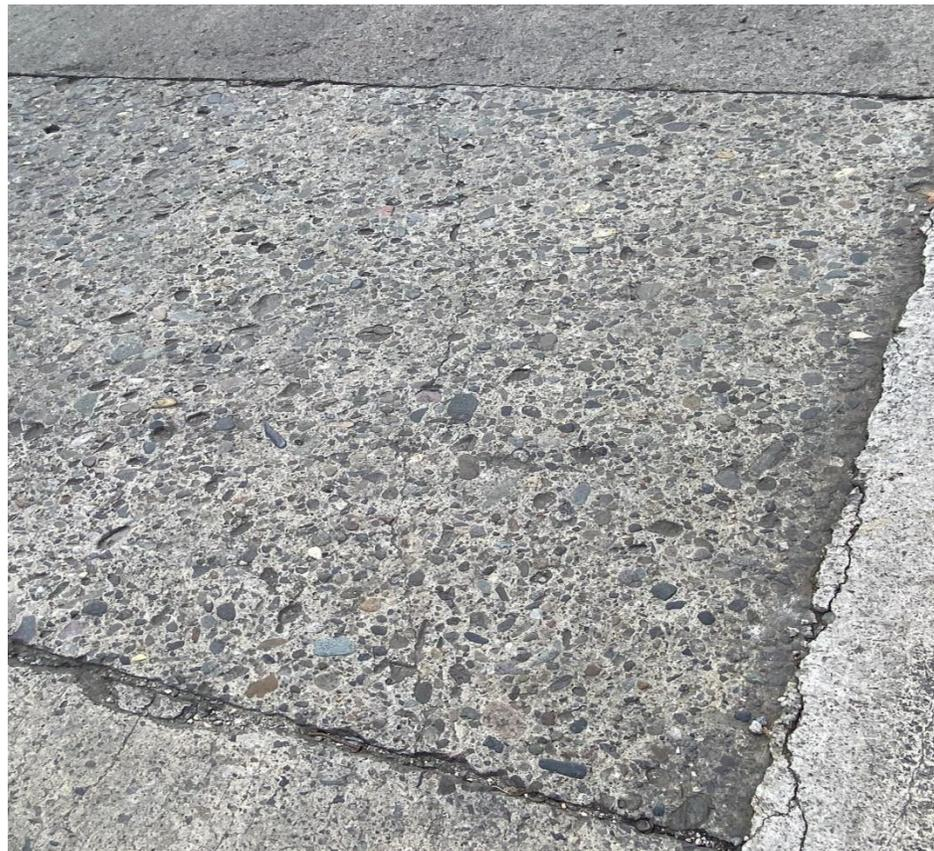
Ilustración 2 - 23: Pulimento de agregados, Fuente: Autor
