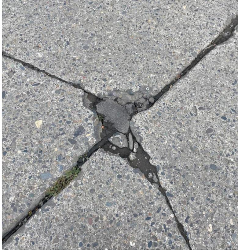
Ilustración 2 - 11: Descascaramiento de esquina de baja severidad,
