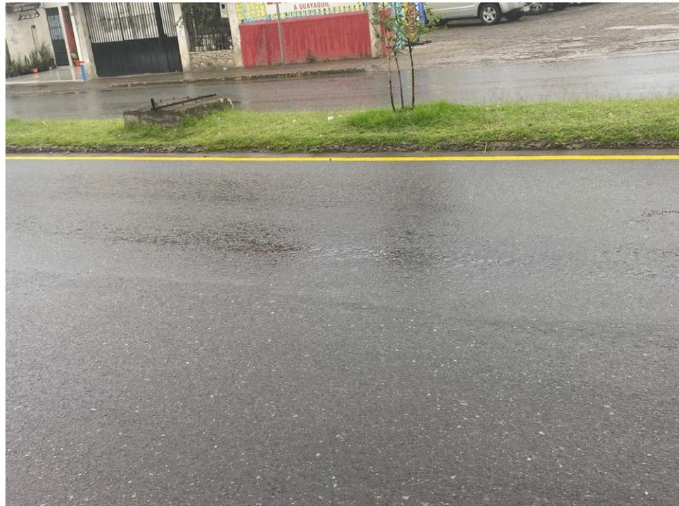
Ilustración 2 - 25: Ahuellamiento de baja severidad, Fuente: Autor
