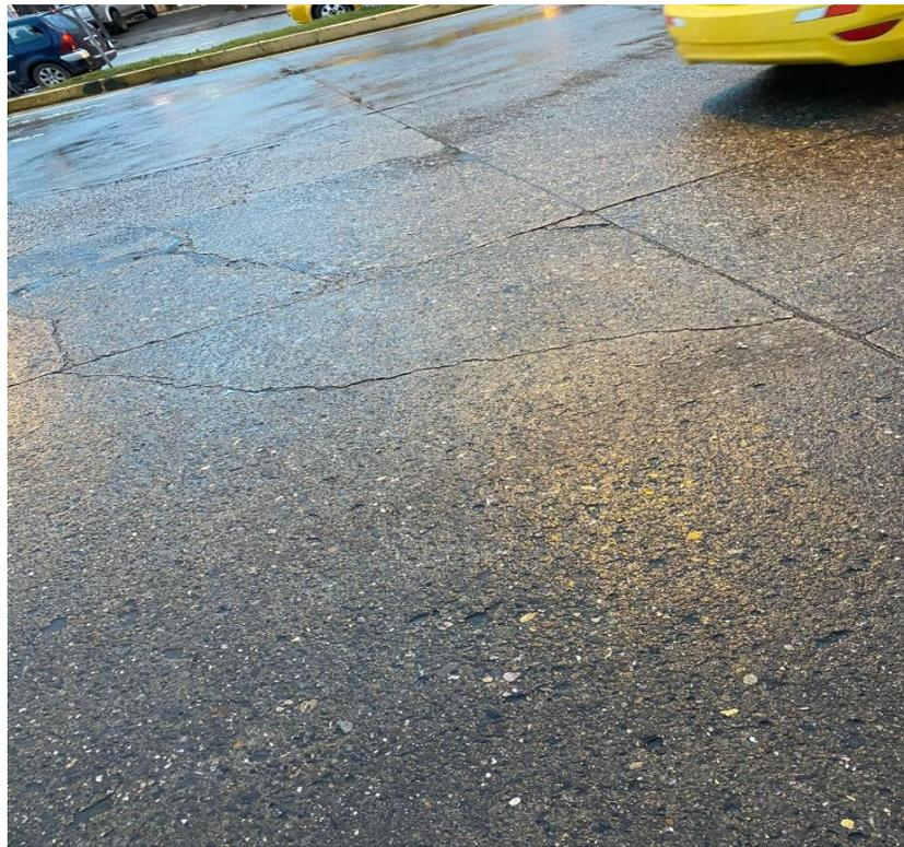
Ilustración 2 - 1: Grieta de esquina de baja severidad, Fuente: Autor
