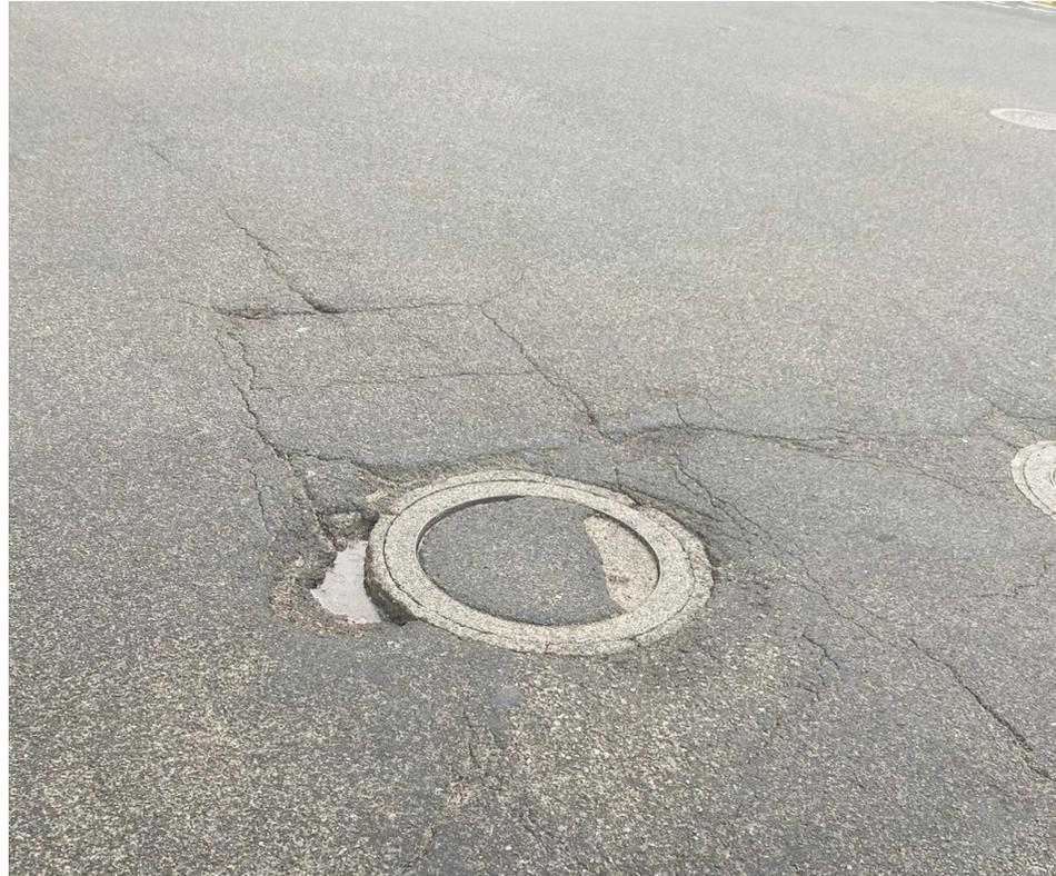
Ilustración 2 - 15: Agrietamiento en bloque de baja severidad, Fuente: Autor
