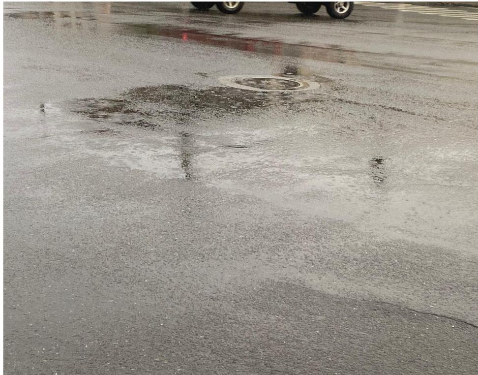
Ilustración 2 - 16: Abultamiento de baja severidad, Fuente Autor
