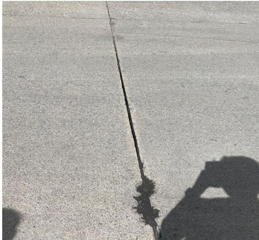
Ilustración 2 - 4: Daño en sello de junta de baja severidad, Fuente: Autor
