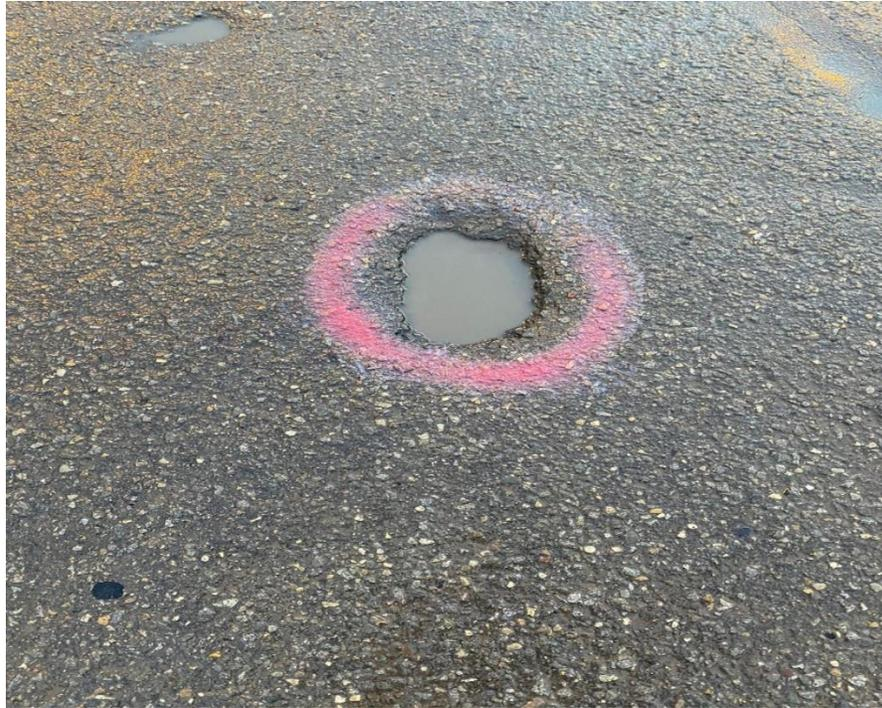
Ilustración 2 - 24: Huevo de baja severidad, Fuente: Autor
