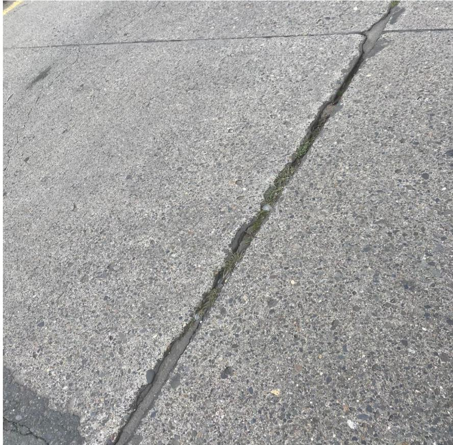
Ilustración 2 - 12: Descascaramiento de junta de baja severidad, Fuente: Autor
