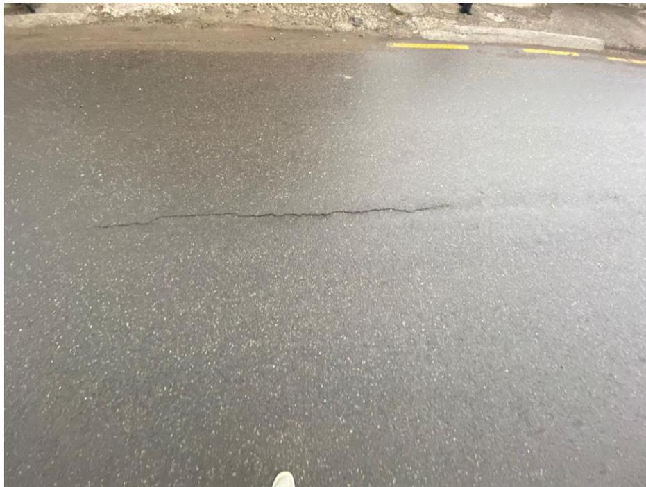
Ilustración 2 - 21: Grieta longitudinal de baja severidad, Fuente: Autor
