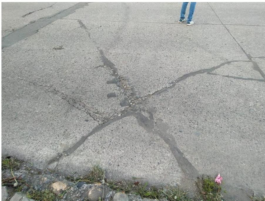
Ilustración 2 - 2: Losa dividida de mediana severidad, Fuente: Autor
