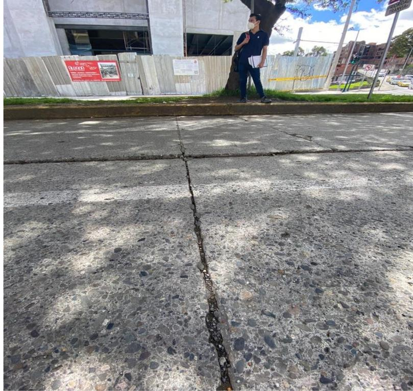
Ilustración 2 - 3: Escala de baja severidad, Fuente: Autor
