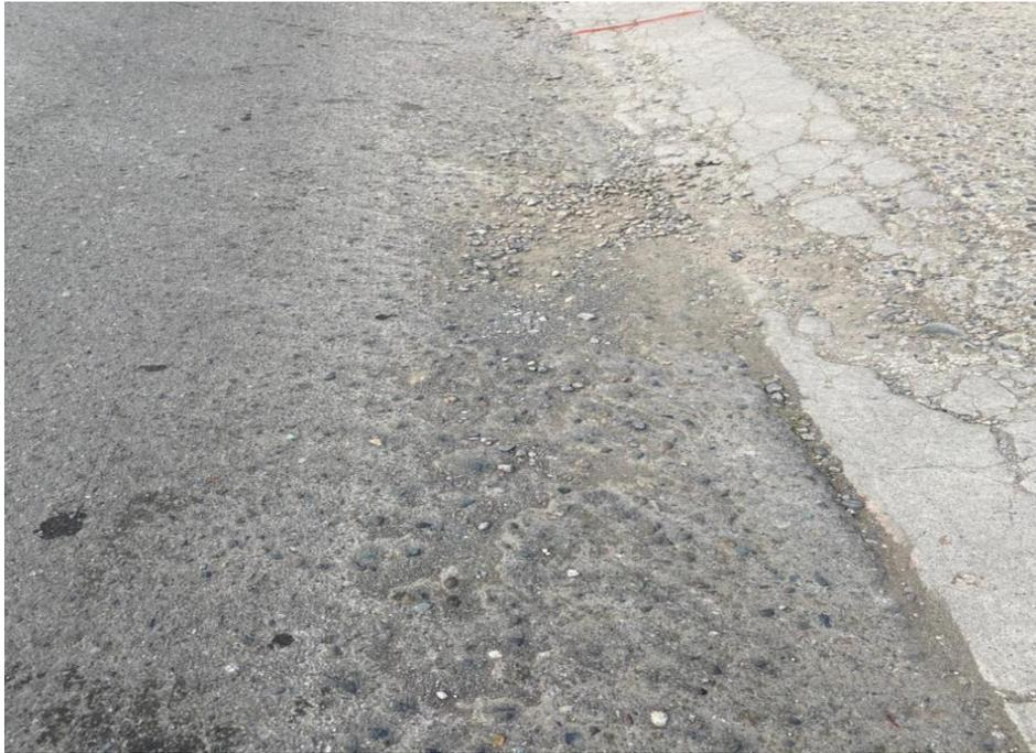
Ilustración 2 - 27: Desprendimiento de agregados de mediana severidad, Fuente: Autor
