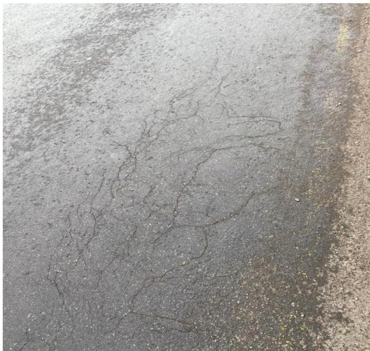
Ilustración 2 - 13: Piel de cocodrilo de baja severidad, Fuente: Autor
