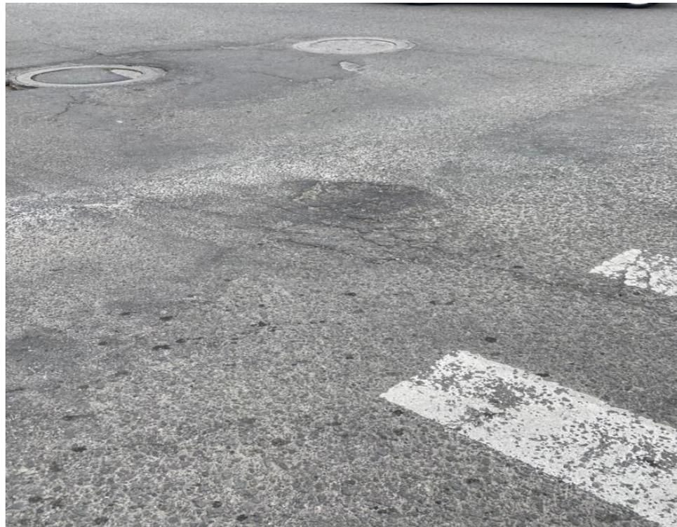
Ilustración 2 - 26: Grietas parabólicas de mediana severidad, Fuente: Autor
