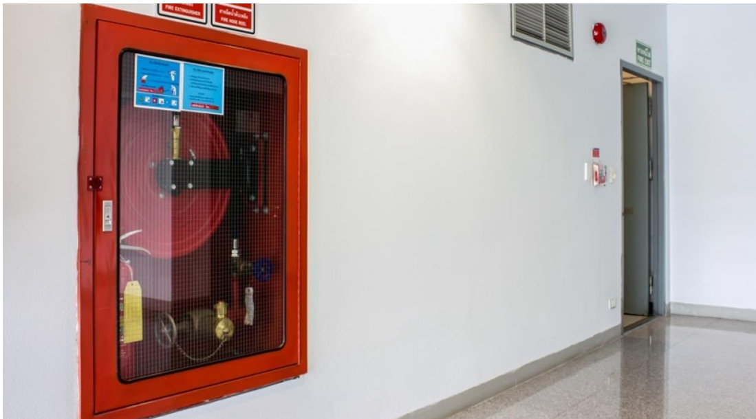
Figura 3.2: Gabinete de manguera de 30m Fuente: (PREVINSIA, 2020)
