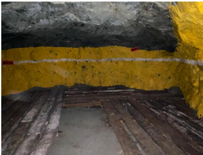
Figura 12 Bodega de explosivos de la Sociedad Minera Reina del Cisne
