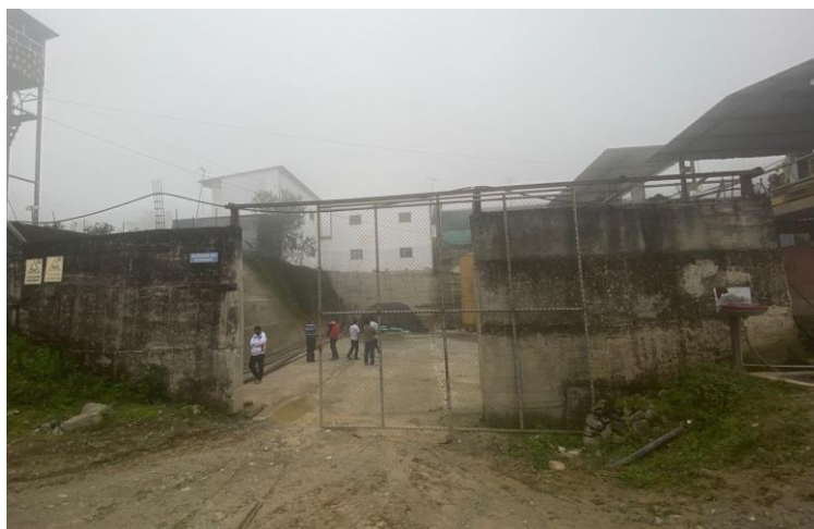
Figura 17 Bodega de almacenamiento de material de la Sociedad Minera Las Palmas
