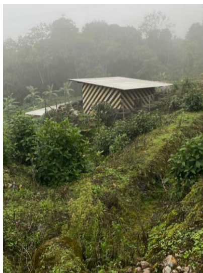
Figura 16 Bodega de explosivos de la Sociedad Minera Las Palmas
