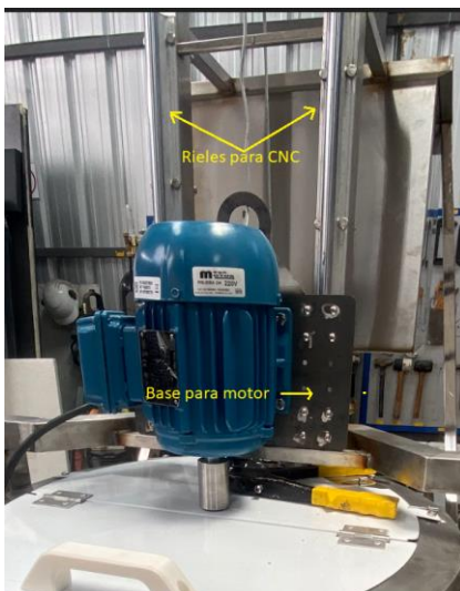
Figura. 35. Montaje de motor agitador y rieles.
