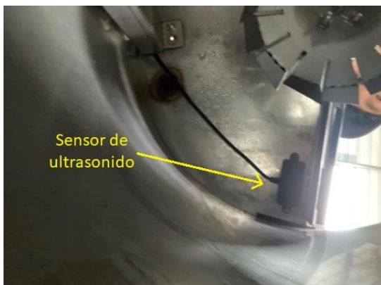
Figura.52. Colocación de sensor ultrasónico en el tanque de almacenamiento.
