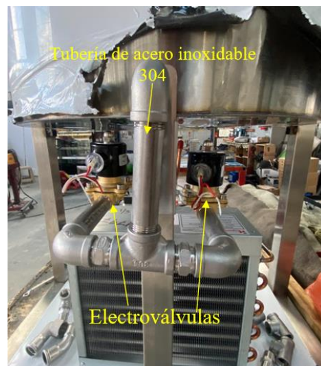
Figura. 37, Montaje de la tubería de 1/2 de acero inoxidable
