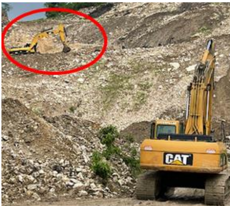
Ilustración 16. Caída de objetos de las plataformas. Fuente: Propia (2022).
