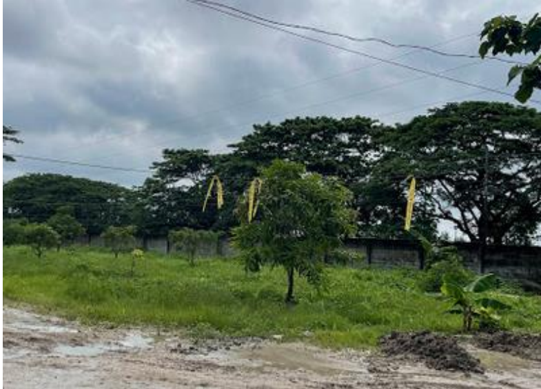
Ilustración 19. Fundas plásticas colocadas en cables eléctricos. Fuente: Propia (2022).
