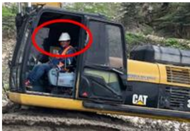
Ilustración 11. Foto que evidencia la exposición al ruido. Fuente: Propia (2022).
