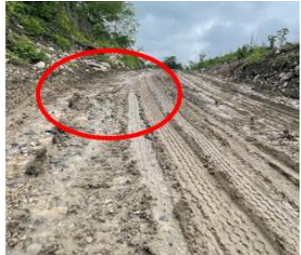
Ilustración 13. Ausencia de cunetas y peralte de vía. Fuente: Propia (2022)
