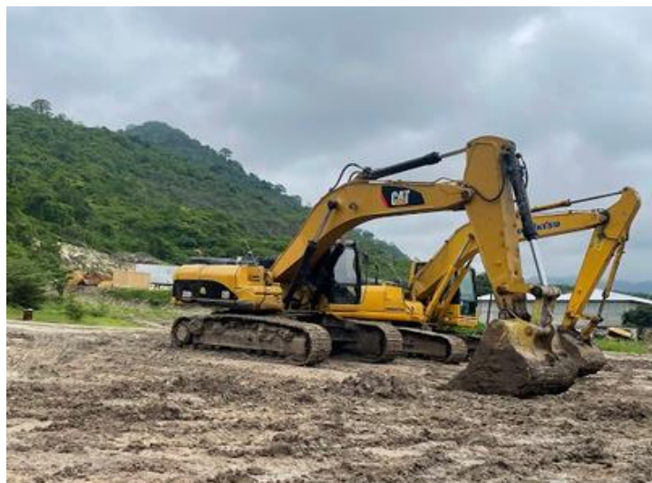
Ilustración 14. El área de almacenamiento no cuenta con infraestructura. Fuente: Propia (2022).
