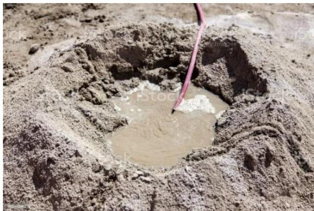
**Figura 1.8.** *Hidratación para fabricación de hormigón*
