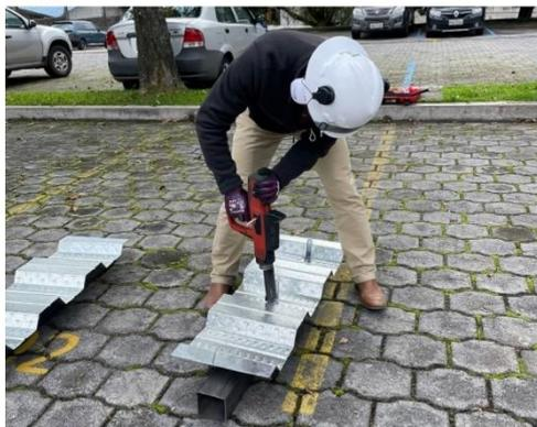
*Instalación de los conectores X-HVB 95 con el uso de la pistola DX-76*
