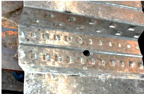
**Figura 2.22.** Perforación en la losa deck para instalar los conectores de cortante
