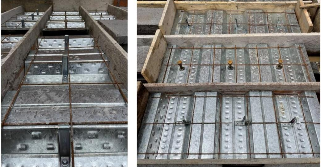
**Figura 2.17.** Colocación de malla electrosoldada y encofrado de las probetas
