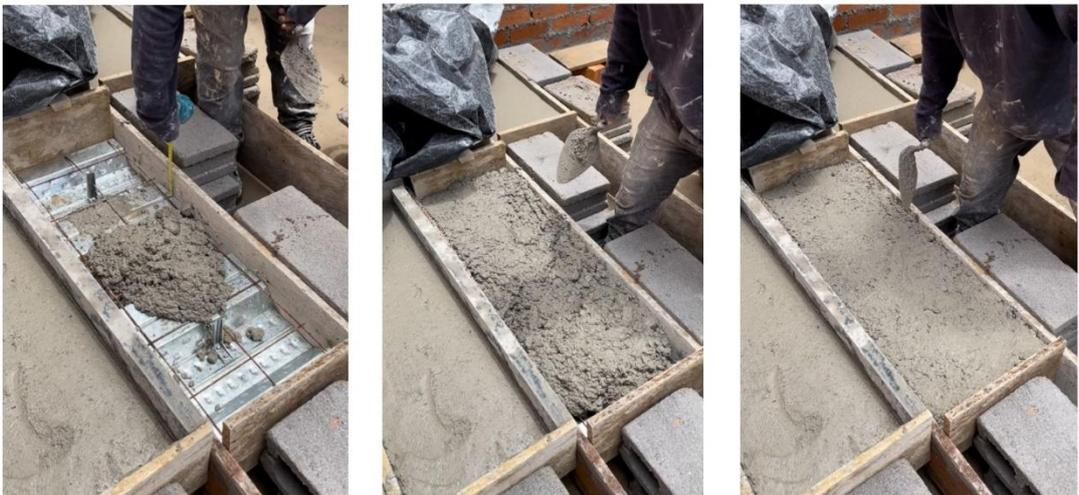
**Figura 2.18.** Proceso de fundición de los modelos a escala de una sección compuesta que utiliza conectores de cortante X-HVB
