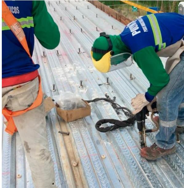
**Figura 2.1.** Aplicación real de losas compuestas
