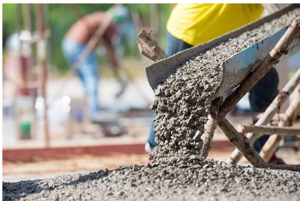
**Figura 1.5.** Vertido de hormigón
