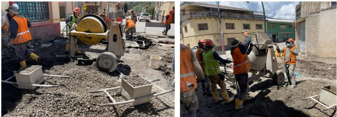
**Figura 2.7.** Elaboración de hormigón 210 kg/cm<sup>2</sup> en obra con el uso de parihuelas y concretera
