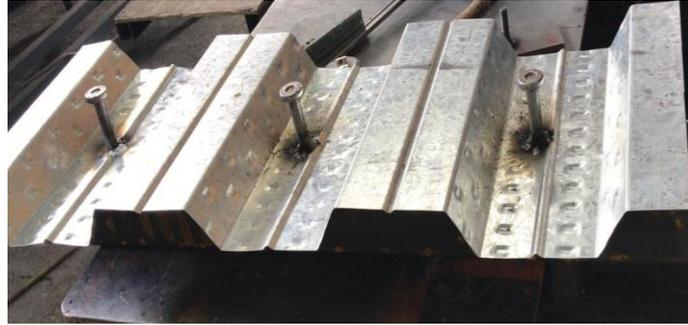
*Figura 2.31. Sección con conectores tipo perno*
