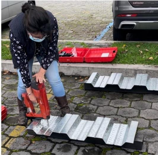
*Colocación de anclajes o fijadores previos a la instalación de los conectores X-HVB*
