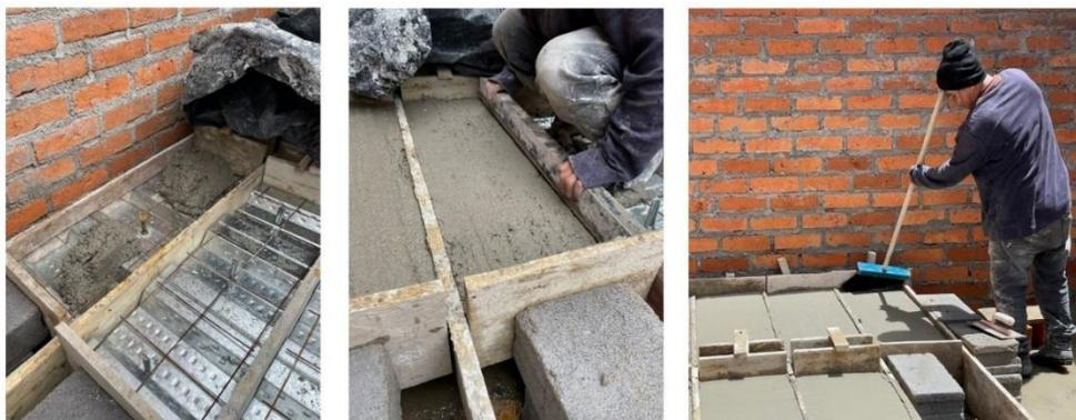
**Figura 2.25.** Proceso de fundición de los modelos a escala de una sección compuesta que utiliza conectores de cortante tipo Stud o Perno
