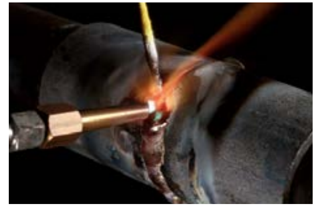
Imagen 3 Soldadura a gas
