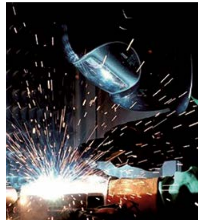
Imagen 4 Soldadura por arco
