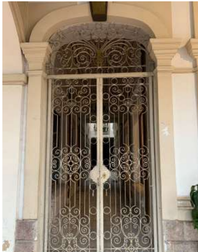
Figura 69: Entrada al pasaje (calle Simón Bolívar), Autoría propia, 2022.
