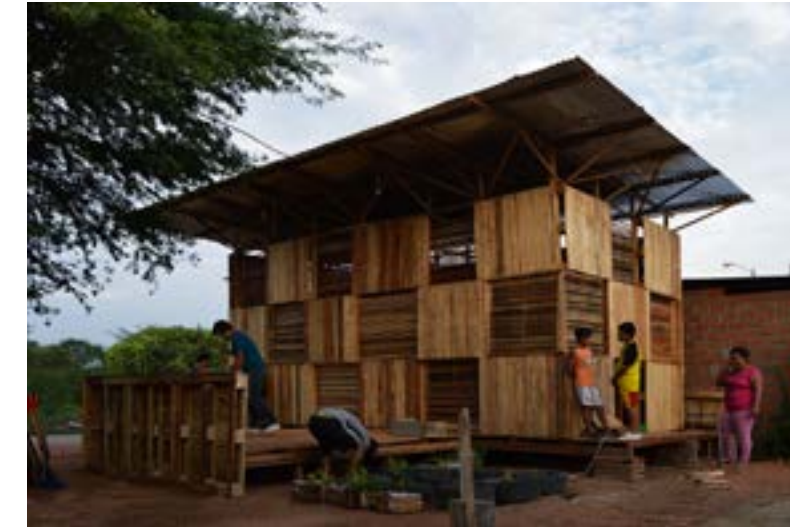
Figura 3: Vivienda Social en Ecuador. Proyecto Chacras Fuente: Plataforma Arquitectura (2016)
