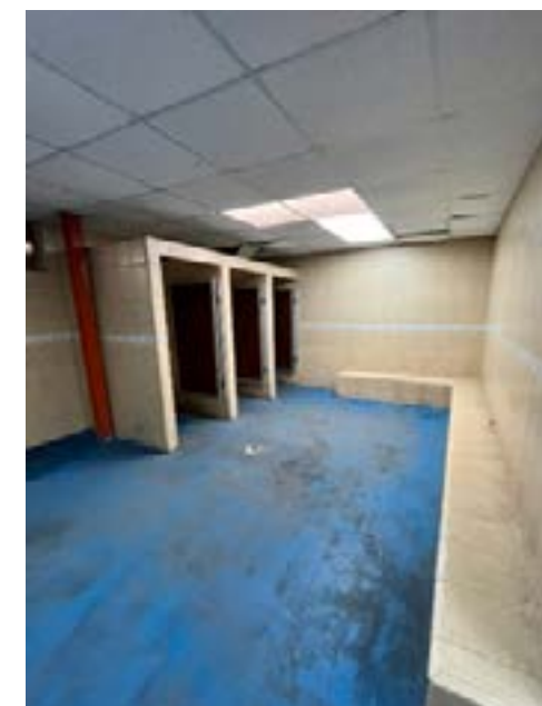
Imagen 35: Interior baños y camerinos mujeres. Fuente: Fotografía Propia.
