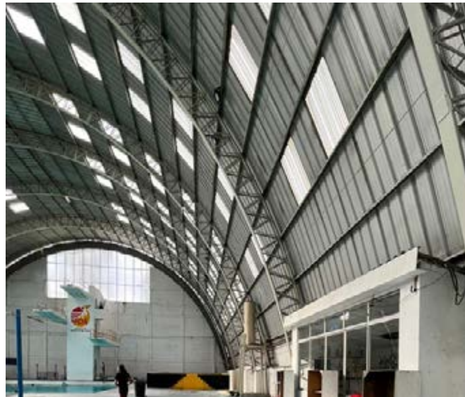
Imagen 7: Tragaluces inferior y superior del cielo raso de la Piscina Olímpica. Autor: Fotografía propia
