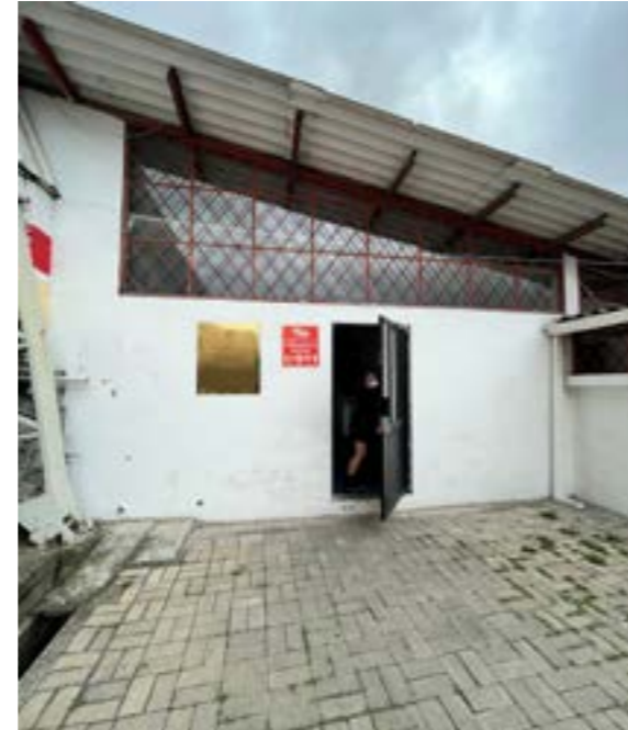
Imagen 45: Estado actual de la zona de recepción. Fuente: Elaboración Propia.
