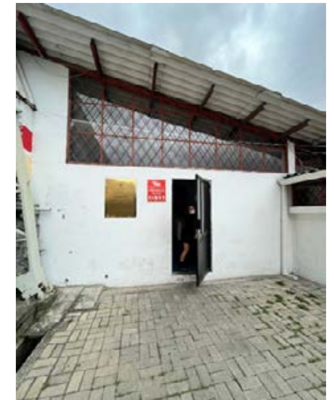
Imagen 38: Ingreso exterior deportistas Piscina Olímpica. Fuente: Fotografía Propia.
