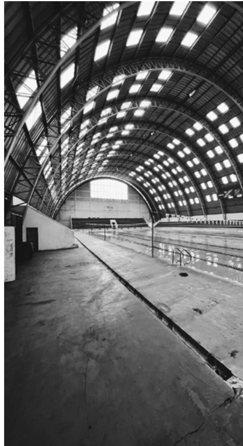
Imagen 41: Estado actual de la Piscina Olímpica. Fuente: Elaboración Propia.
