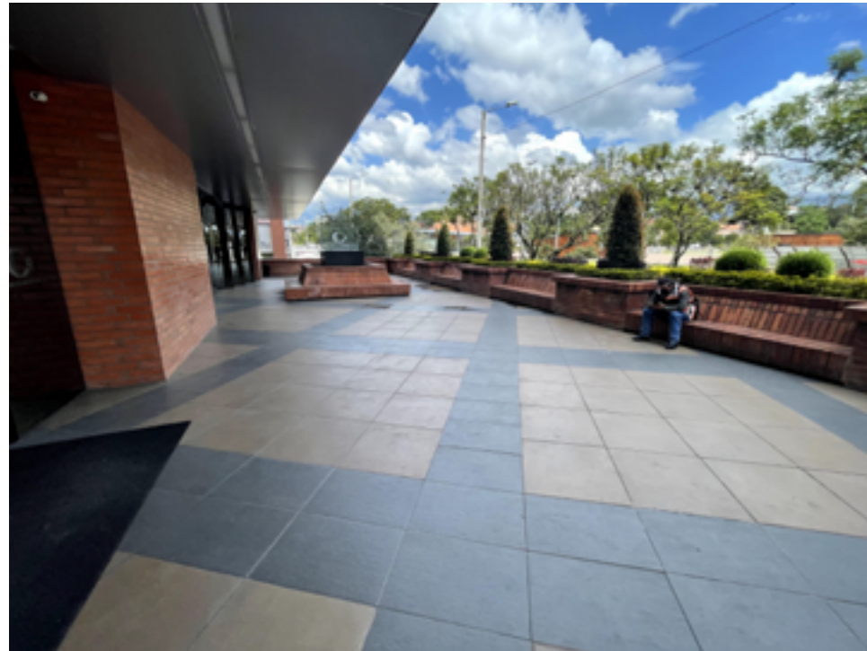
Figura 19: Acceso de la edificación a Cámara de Industrias de Cuenca
