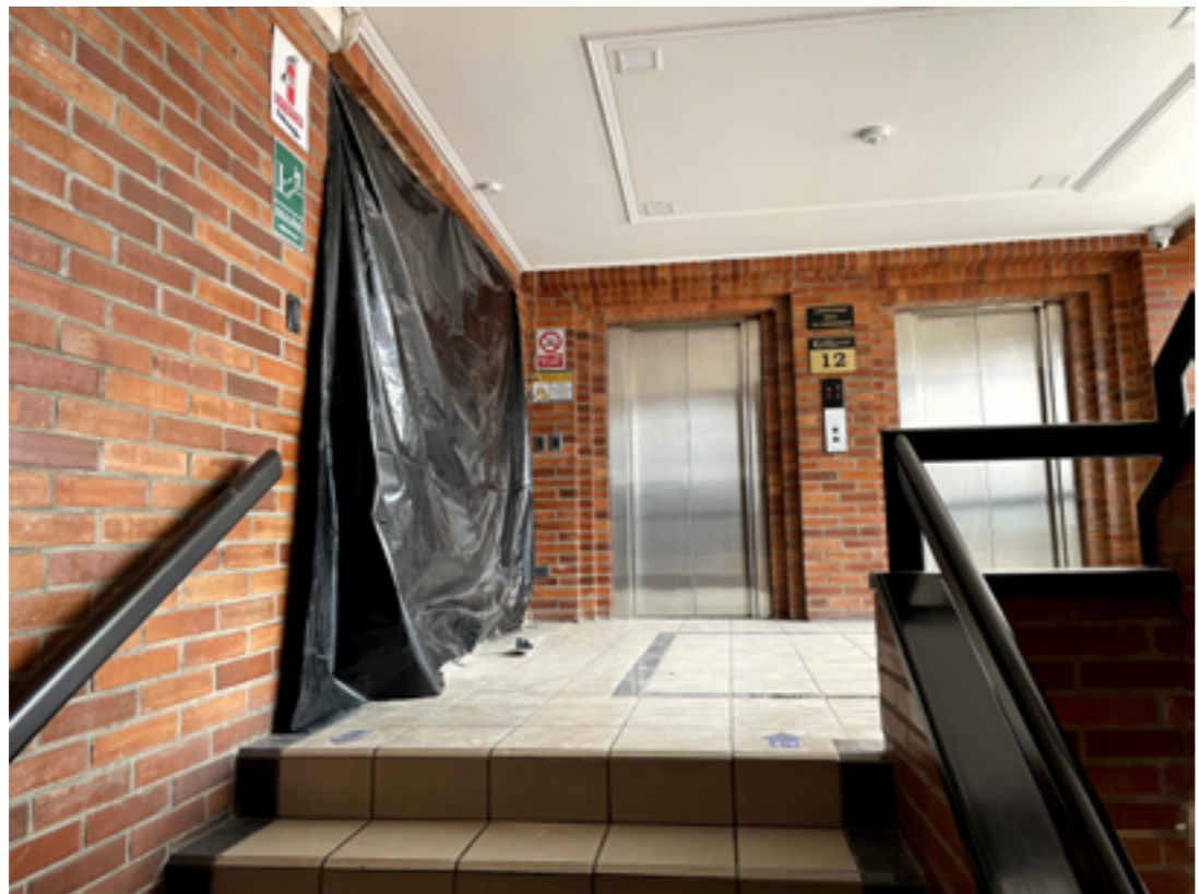
Figura 38: Piso en Construcción
