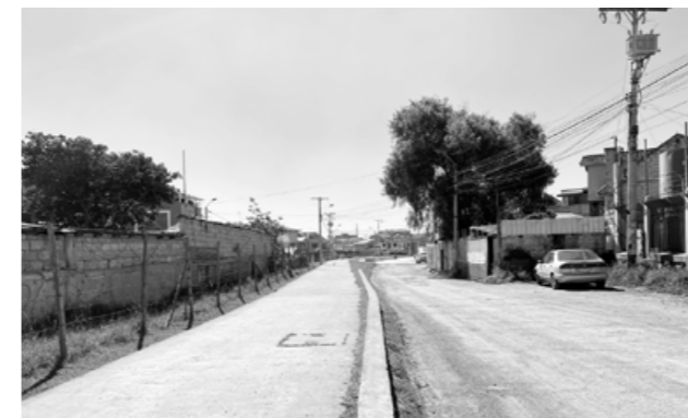
Tramo 04. Quebrada embaulada Situación Actual
