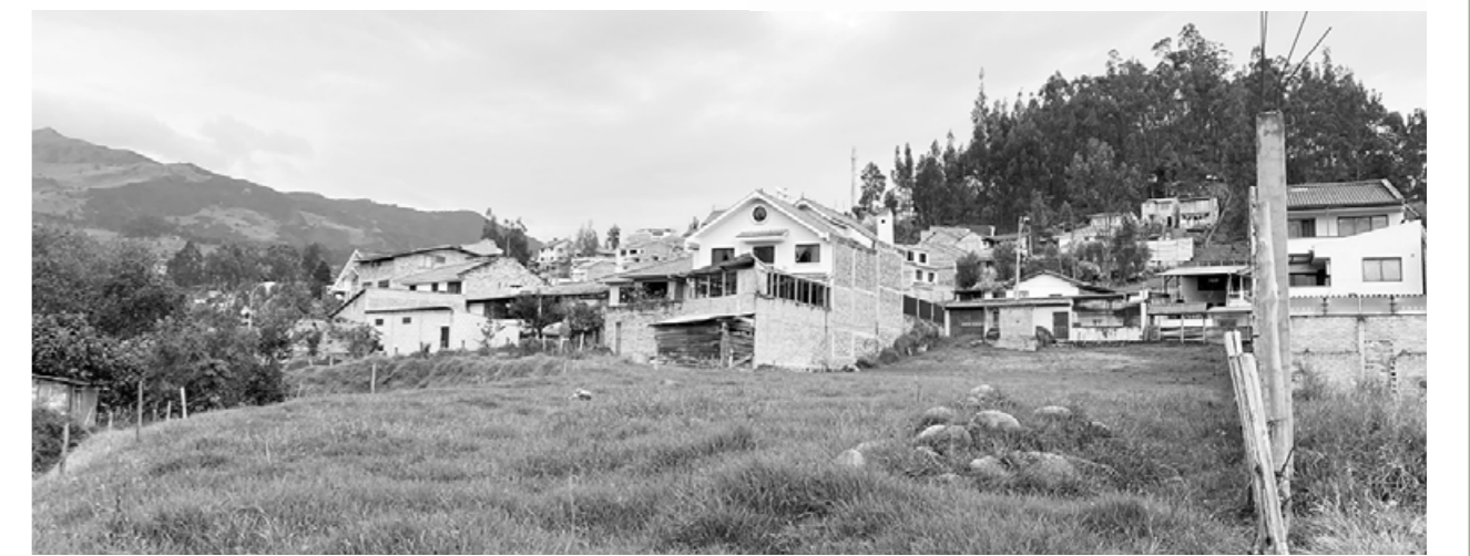
Tramo 01. Sector Camino Viejo a Baños Situación Actual
