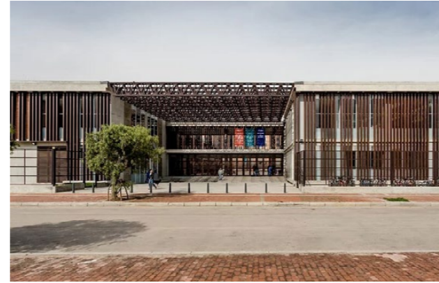
Fig. 72. Fachada principal Fuente: Colectivo 720 (2015)
