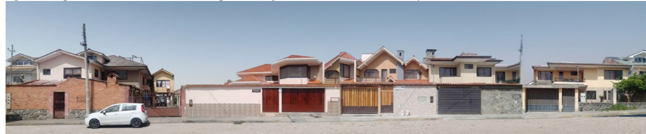
Fig. 123. Fotografía (VISTA OESTE) Fuente: Autoría Propia
