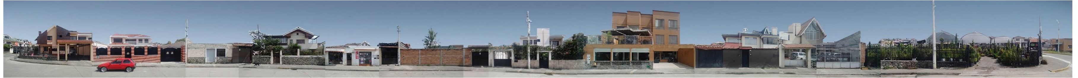
Fig. 121. Fotografía (VISTA OESTE) Fuente: Autoría Propia
