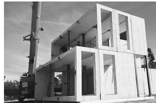
Fig. 35. Construcción industrializada. Fuente: Solís, P. (1992).
