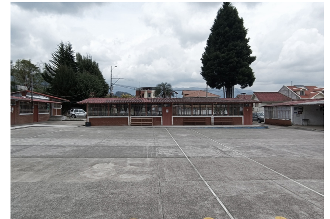
Fig. 94. Vista del carretero sur. Fuente: Elaboración propia
