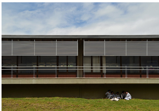
Fig. 37. Vista frontal de bloque de aulas. Fuente: BAQ (2014)
