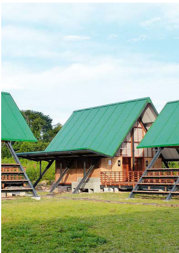
Fig. 51. Vista de una tipología de emplazamiento. Fuente: Construcción y Vivienda (2017)
