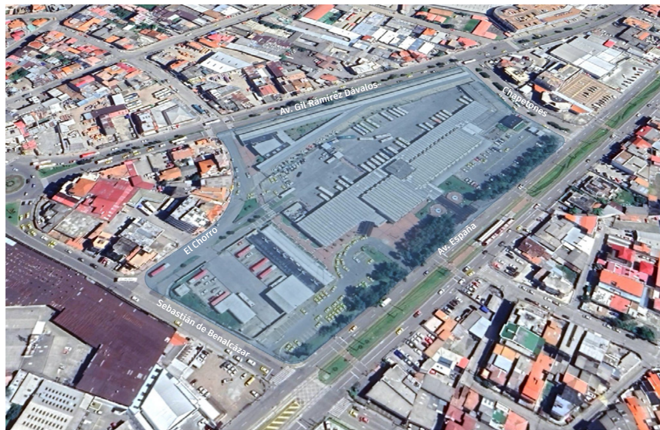
Figura 111. Emplazamiento, estado actual Terminal Terrestre de Cuenca. Fuente propia
