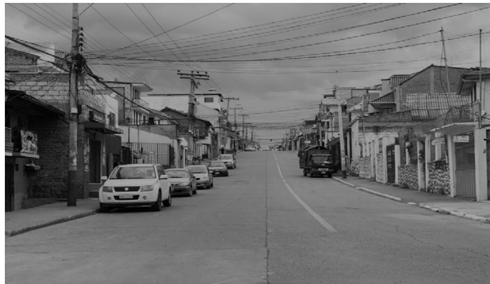
Figura 91. Estado actual de Calle Barrial Blanco Fuente propia
