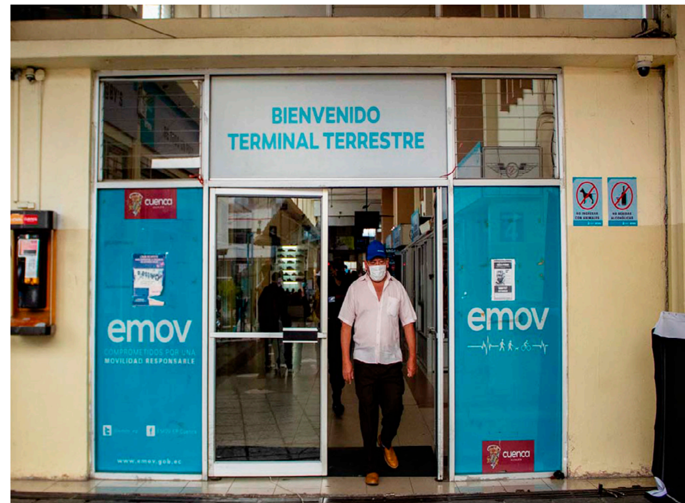
Figura 5. Entrada lateral Oeste al Terminal Terrestre de Cuenca. Fuente propia
