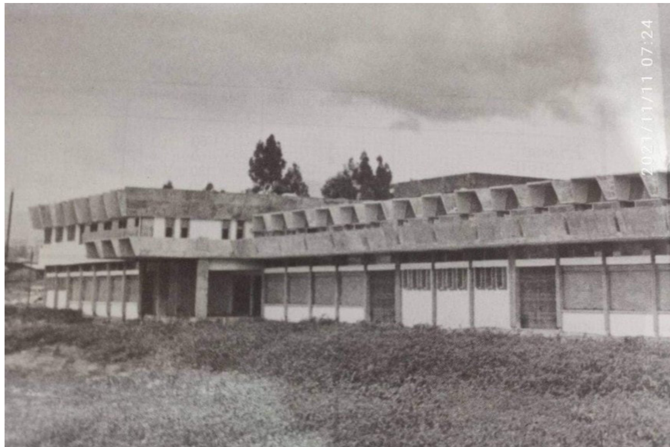
Figura 51. Terminal terrestre de Cuenca en construcción en 1978. Fuente Tomás García
