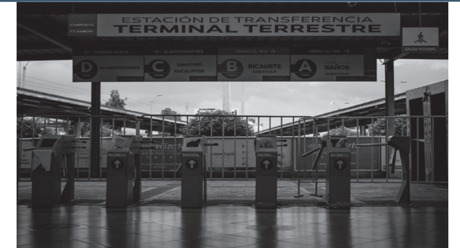
Terminal de transferencia, en la parte posterior del terminal terrestre, actualmente no es utilizada y su infraestructura esta de mal estado.
