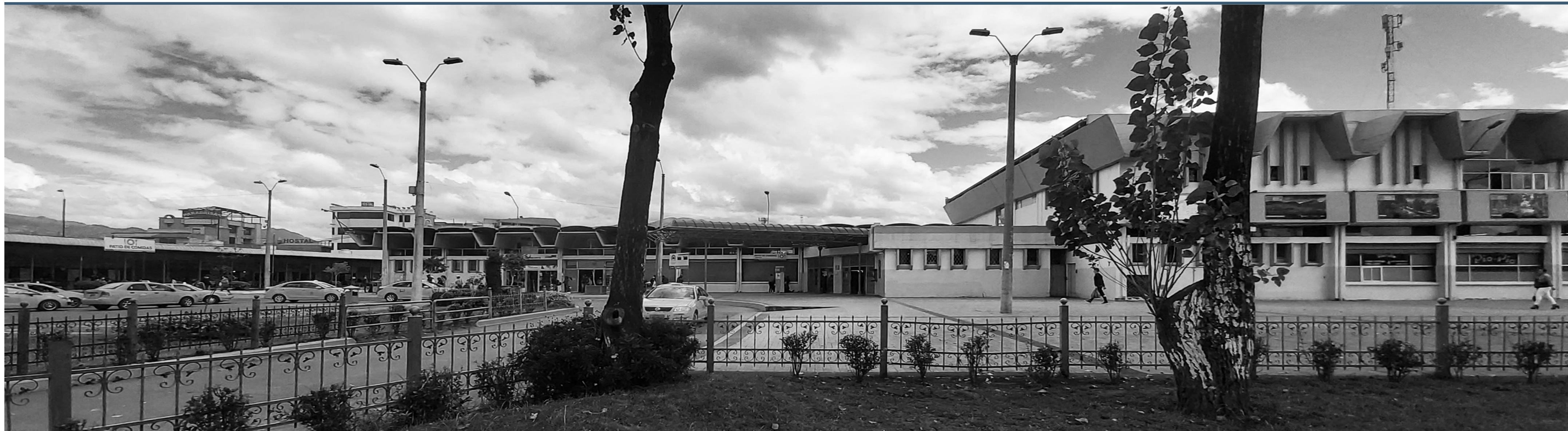
Figura 157. Fachada principal, Estado actual, rehabilitación del Terminal Terrestre de Cuenca. Fuente propia
