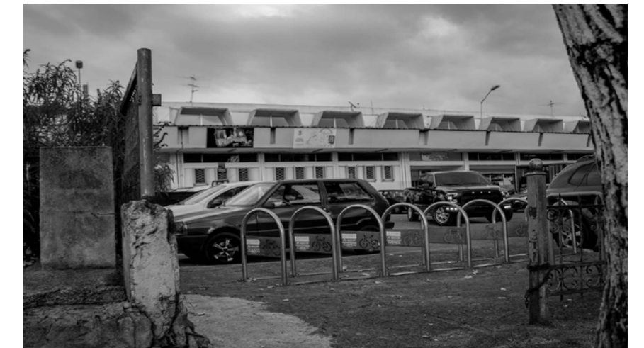
Infraestructura y señalización, en mal estado, sin utilizar, además de no estar ubicados en lugares estratégicos, cerca del flujo de personas.
