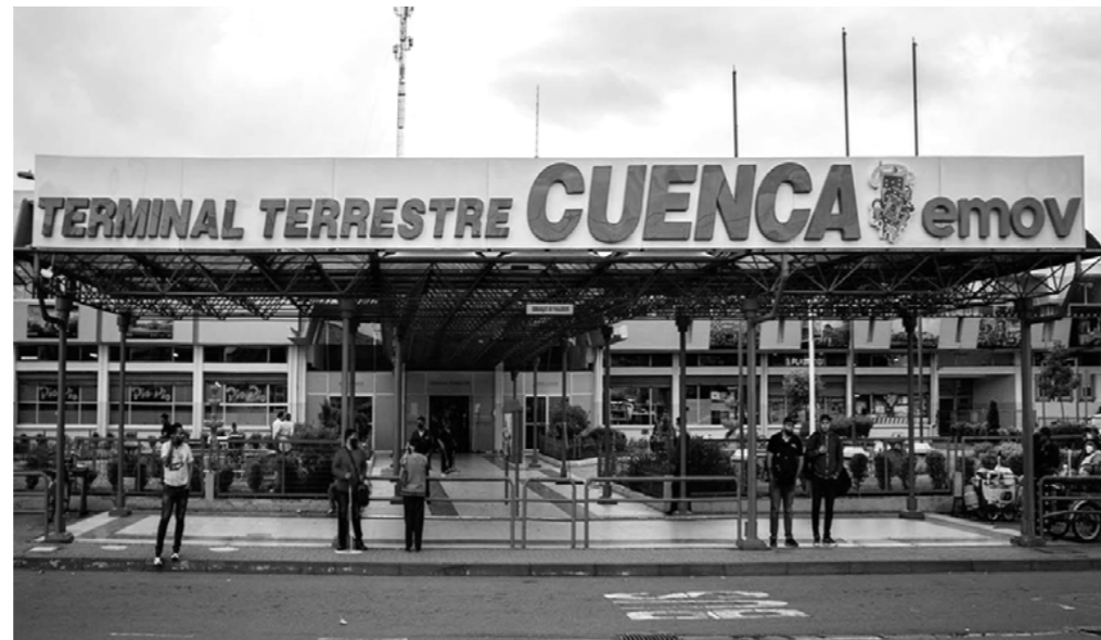
Figura 92. Estado Actual del espacio en donde se implementara un para de bus. Fuente propia
