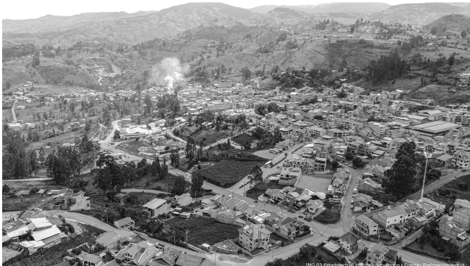
IMG 03 Estado actual lote de intervención | Fuente: Elaboración propia
