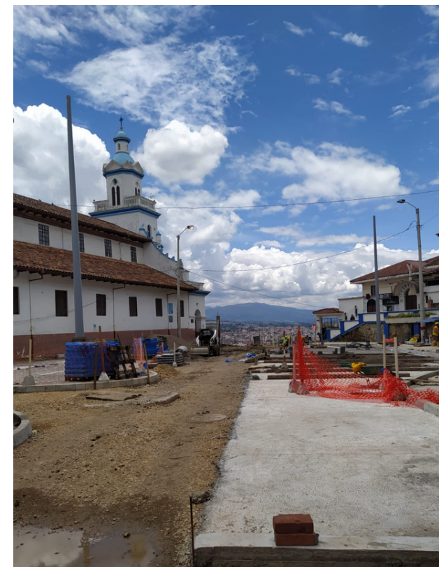
Imagen 27: Vías en construcción Fuente: Elaboración propia, 2022
