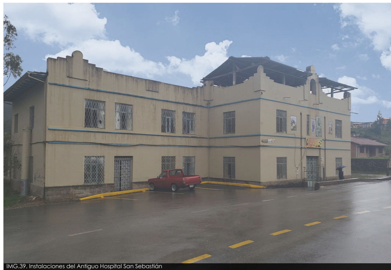
IMG.39. Instalaciones del Antiguo Hospital San Sebastián
