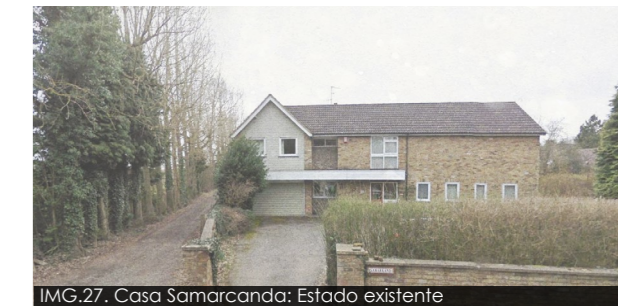
IMG.27. Casa Samarcanda: Estado existente
