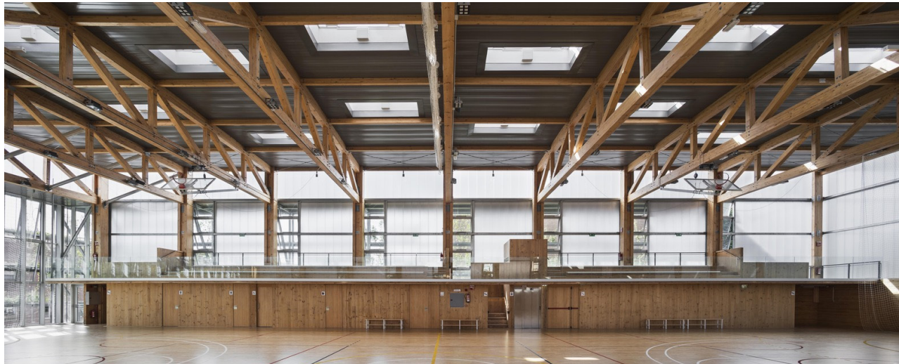
Imagen 10. Vista interna de la zona cancha multiusos
