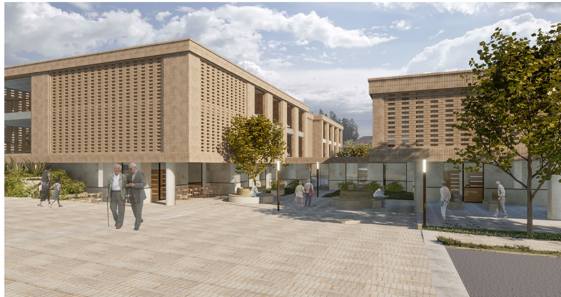
Fig. 156:Vista Edificios A-B. Fuente: Autoría propia.
