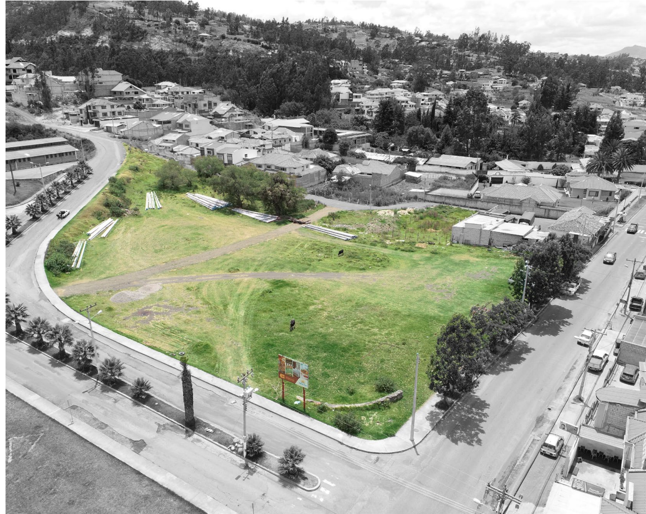
Fig. 144: Estado actual. Crédito: Ing. Sánchez, E.
