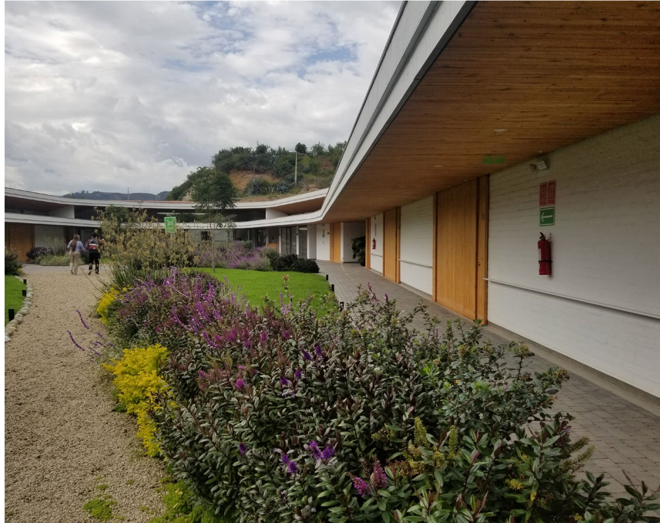
Fig. 70: Patios internos. Fuente: Autoría propia.
