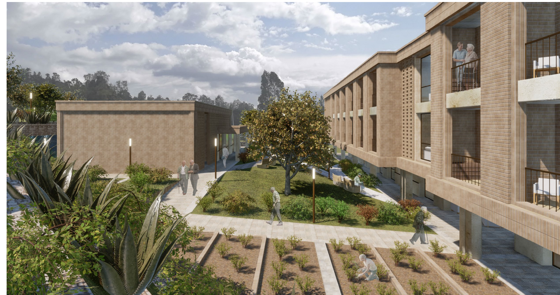
Fig. 158: Vista Edificio C-D. Fuente: Autoría propia.
