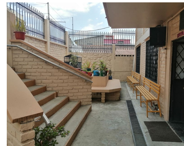
Fig. 85: Ingreso principal. Fuente: Autoría propia.
