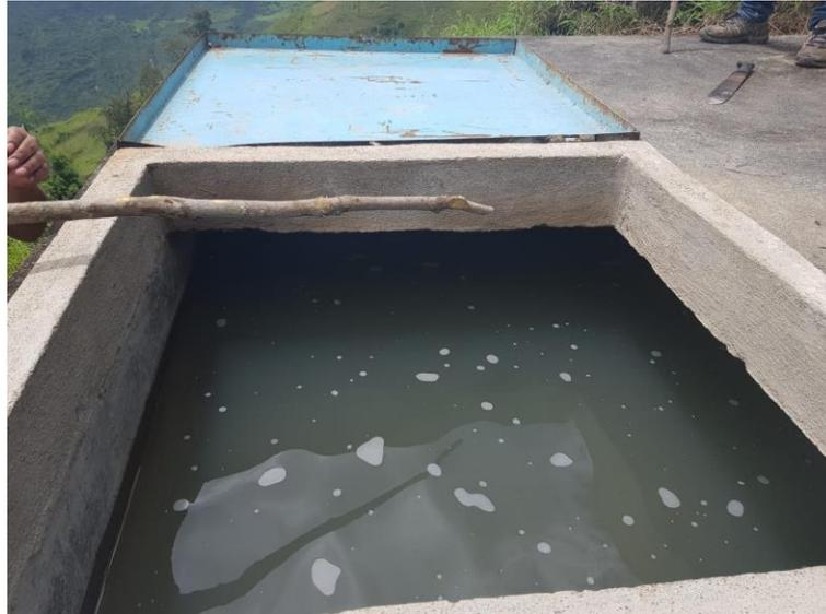
Figura 1.18 Tanque Filtro lento, calidad de agua
