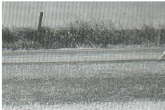
Ilustración 2-5: Corrugación de baja severidad Fuente: Vásquez, 2002.
