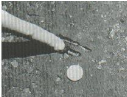
Ilustración 2-2: Exudación de media severidad Fuente: Vásquez, 2002.
