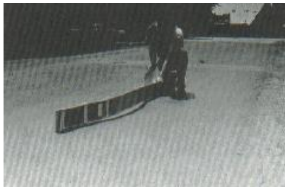
Ilustración 2-16: Desplazamiento de baja severidad, Fuente: Vásquez, 2002.
