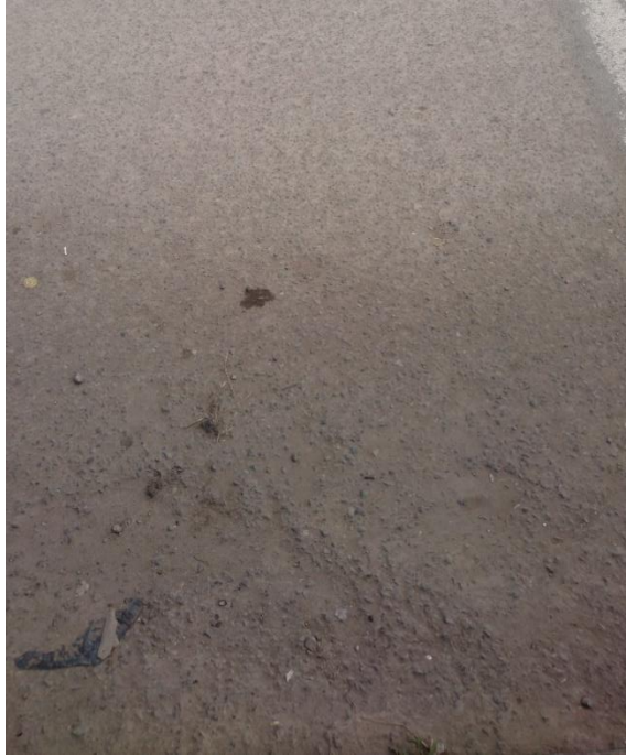
Ilustración 2-19: Meteorización de baja severidad, Fuente: Autor.
