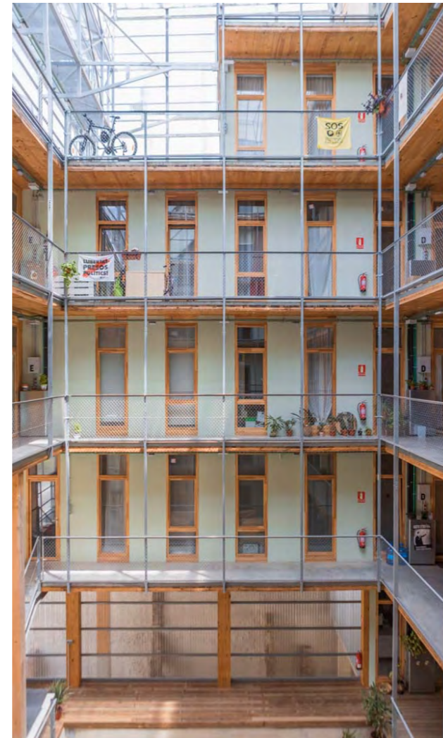
Fig. 41. Interior de la vivienda La Borda Fuente: Anna Bosch, 2018.
