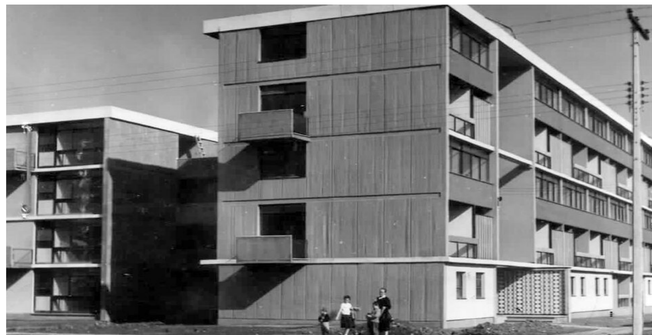
■ ÁREA VIVIENDA 90-120 m 2 ■ MATERIALIDAD Hormigón armado ■ MATERIALIDAD Hormigón armado ■ MATERIALIDAD Hormigón armado ■ SERVICIO DE TRANSPORTE Bus urbano ■ SERVICIOS COMPLEMENTARIOS Salud y educación ■ ÁREAS VERDES Jardines y plazas ■ TIPOLOGÍAS Tres tipologías Dúplex ■ TIPO DE VIVIENDA Unidades de vivienda ■ SISTEMA CONSTRUCTIVO Pórticos ■ UBICACIÓN Centro urbano ■ DENSIDAD 540 Hab/ha
