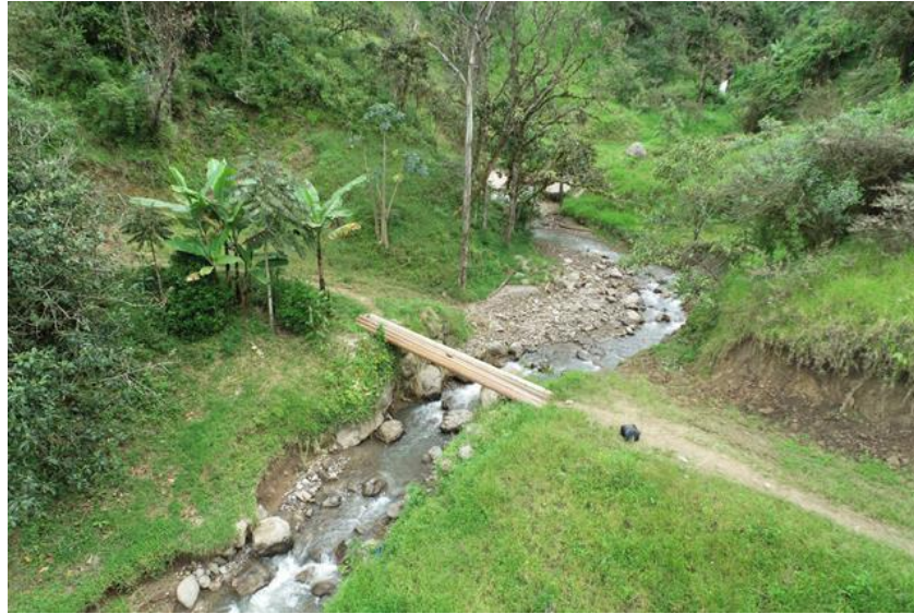
Figura 2: Estructura provisional de puente.
