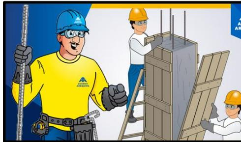
El encofrado es una actividad que consiste en el uso de moldes temporales o permanentes para dar forma al hormigón u otros materiales similares, como la tierra moldeada, antes de que se fragüe. Mientras que el desencofrado son las operaciones que se realizan para el desmontaje del encofrado. Los elementos del encofrado se retiran, sin golpes ni sacudidas, cuando el hormigón alcanza la resistencia suficiente para evitar deformaciones excesivas y fisuras prematuras.
