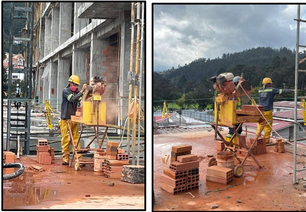
*Ilustración 12. Corte de ladrillos.*
