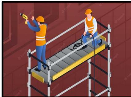
Los andamios son plataformas y elementos auxiliares en la obra, tienen la finalidad de elevarse y permitir realizar trabajos en altura, son construidos provisionalmente y el material más utilizado para su fabricación es el aluminio debido a poseer propiedades de resistencia, rigidez y estabilidad.
