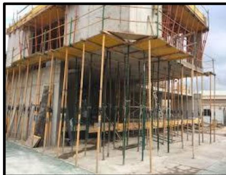
Los puntales tienen la función de soportar cargas para la construcción de forjados, apuntalamiento de encofrados, muros, losas etc.
