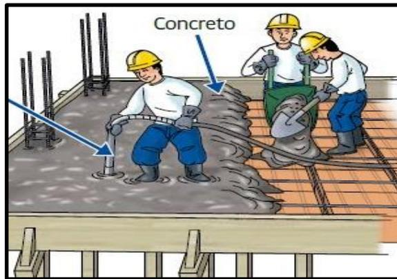
Esta actividad consiste en la colocación del hormigón que es una mezcla formada de cemento, agua, arena, aditivos y grava o piedra triturada; es un material muy resistente, con gran durabilidad y se lo utiliza para la ejecución de columnas, fundición de losas, muros, paredes etc. Para su colocación debe existir una planificación previa y los trabajadores deben estar listos con sus herramientas, equipos y maquinaria adecuada.
