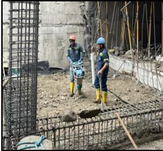
*Ilustración 18. Uso de compactador.*
