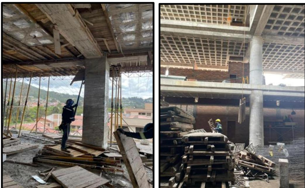
*Ilustración 8. Actividades de montaje y desmontaje.*
