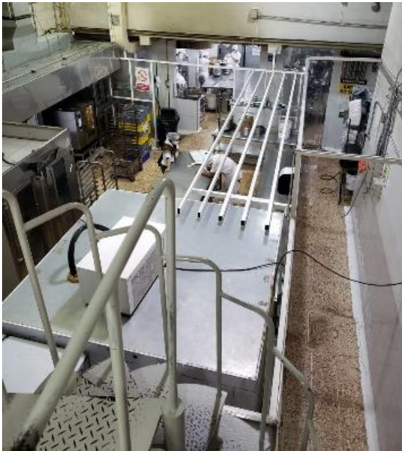
Ilustración 41 Vista de planta desde oficinas
