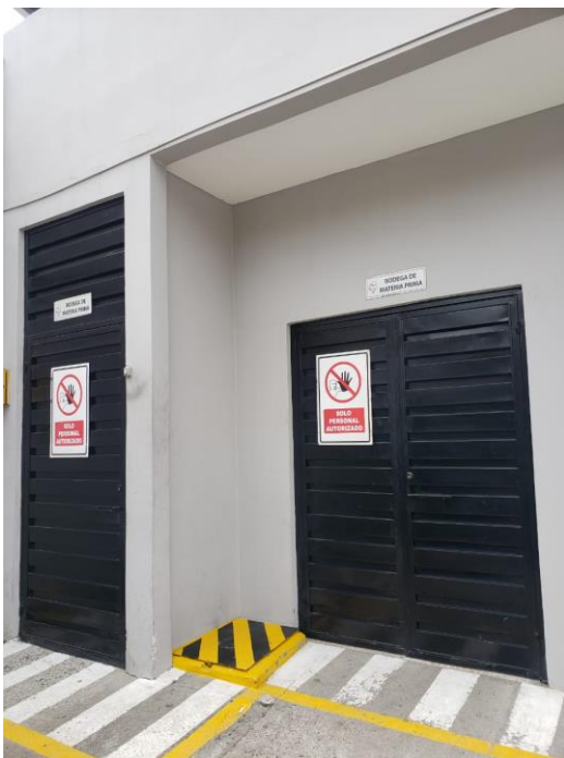
Ilustración 14 Ingreso principal a la planta
