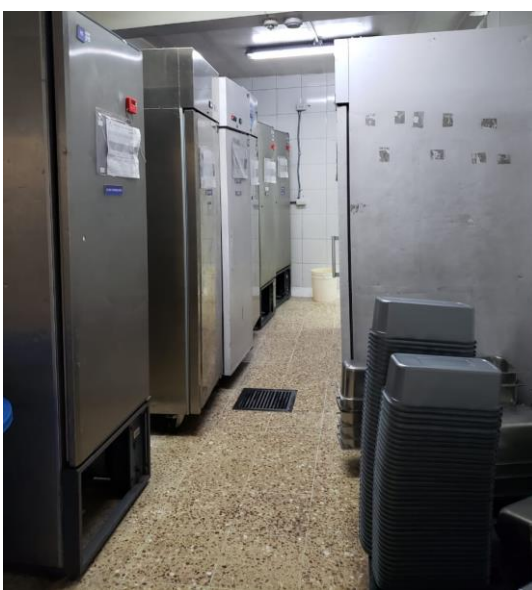
Ilustración 33 Blast chillers (zona de enfriamiento)
