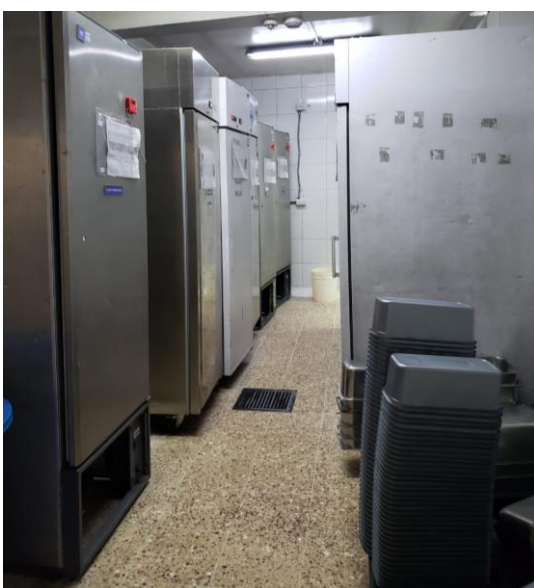
Illustration 33 Blast chillers (zona de enfriamiento)
