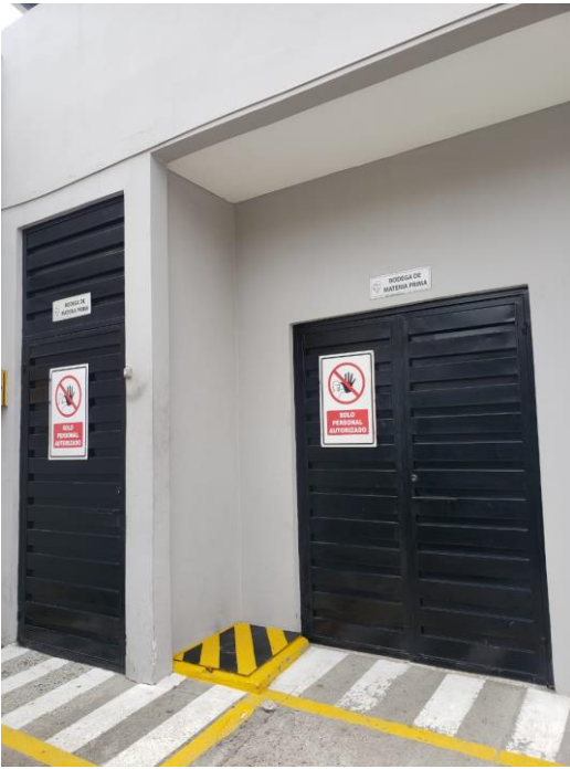
Illustration 14 Ingreso principal a la planta
