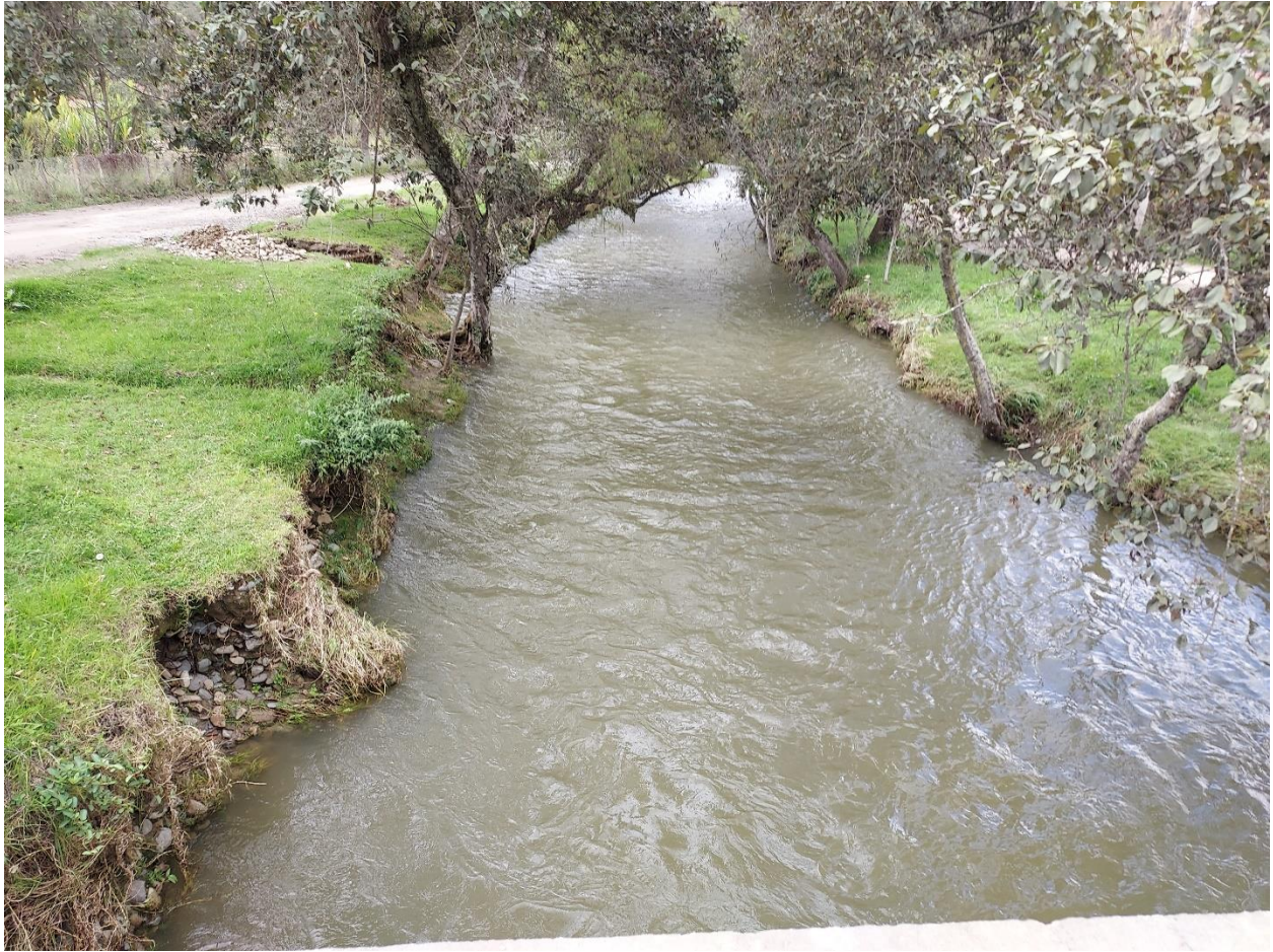
Figura 4.5. Tramo recto antes del puente S/N.
