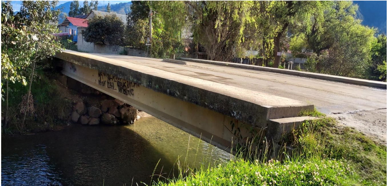
Figura 4.6.Ubicación de la estacion dentro del puente S/N.
