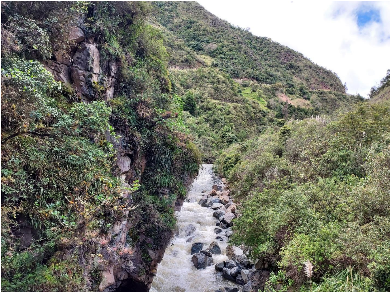
Figura 4.2. Tramo recto antes del puente
