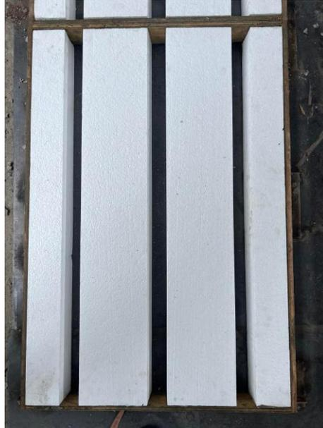
*Figura 5.2. Encofrado de losa con tres nervios*
