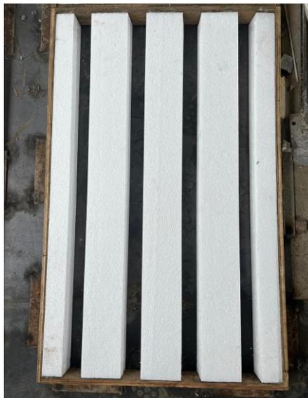
*Figura 5.3. Encofrado de losa con cuatro nervios*
