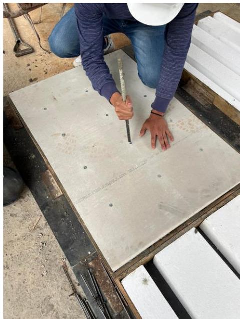
*Figura 5.12. Colocación de la plancha de fibrocemento*
