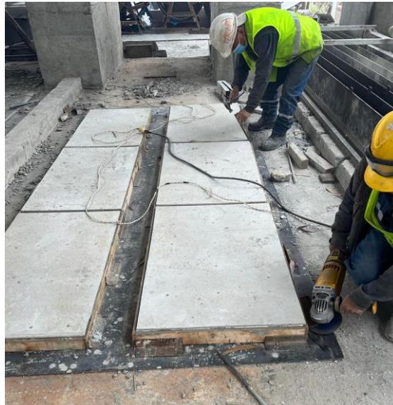
*Figura 5.17. Desencofrado de las losas micronervadas*
