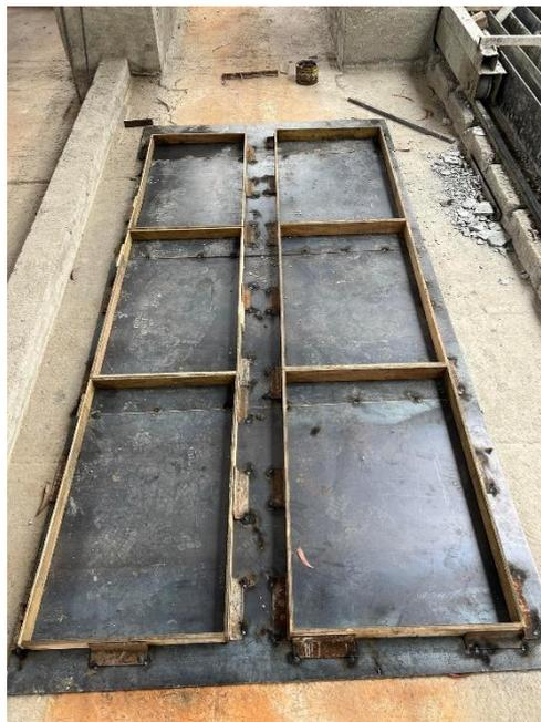
*Figura 5.1. Marcos para el encofrado de las losas*
