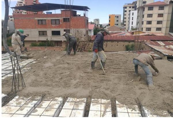
*Figura 2.7. Losa vaciada In Situ*
