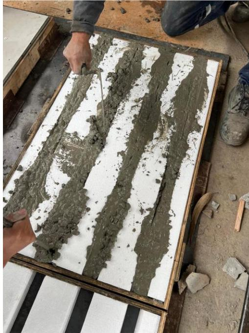
*Figura 5.10. Proceso de vaciado del hormigón*
