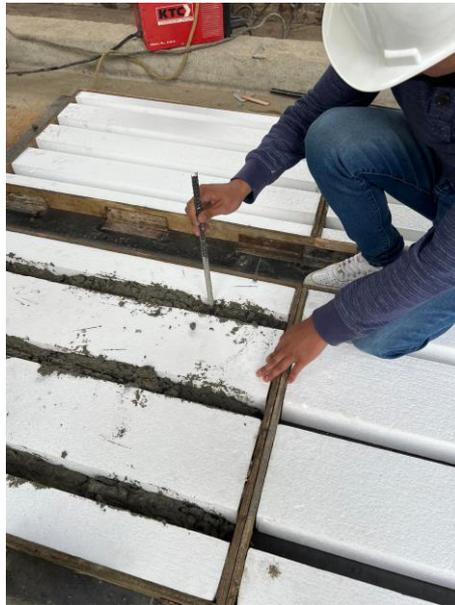
*Figura 5.11. Vibrado del hormigón*
