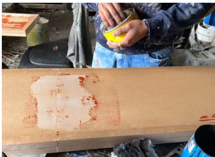
Figura 11: Colocación de cera desmoldante en el molde construido. Fuente: Autores.
