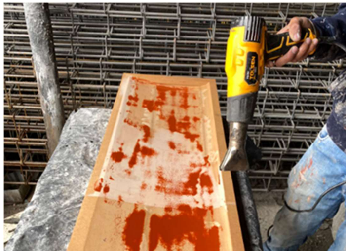
Figura 12: Secado capa de alcohol de polivinilo. Fuente: Autores.
