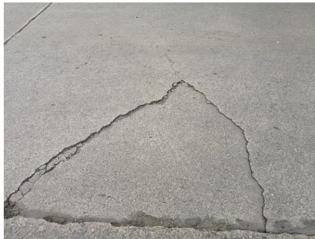
Ilustración 2 - 9: Punzonamiento de mediana severidad, Fuente: Autor
