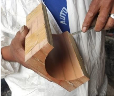
Fig. 12 Masillado de los contornos
