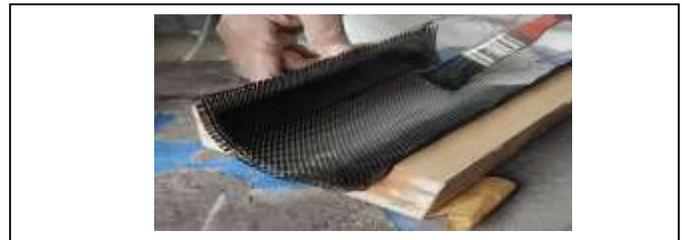
Fig. 13. Colocación de resina para la base del faro.
