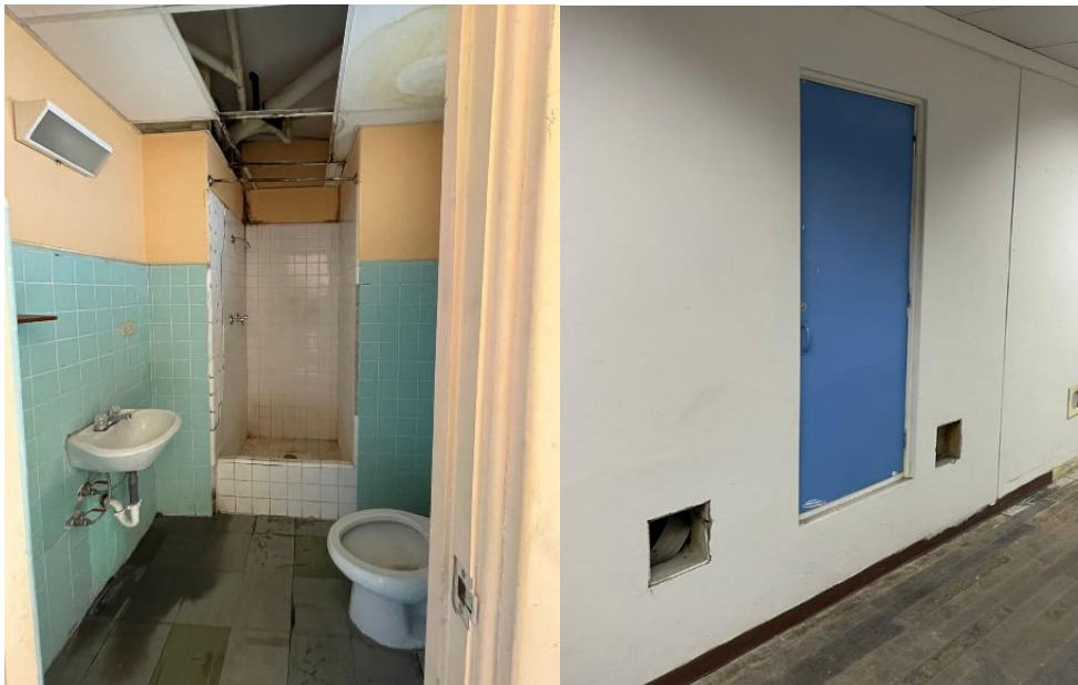
Figura 2.10: Tuberías en el cielo raso y puertas de ductos de bajantes.
