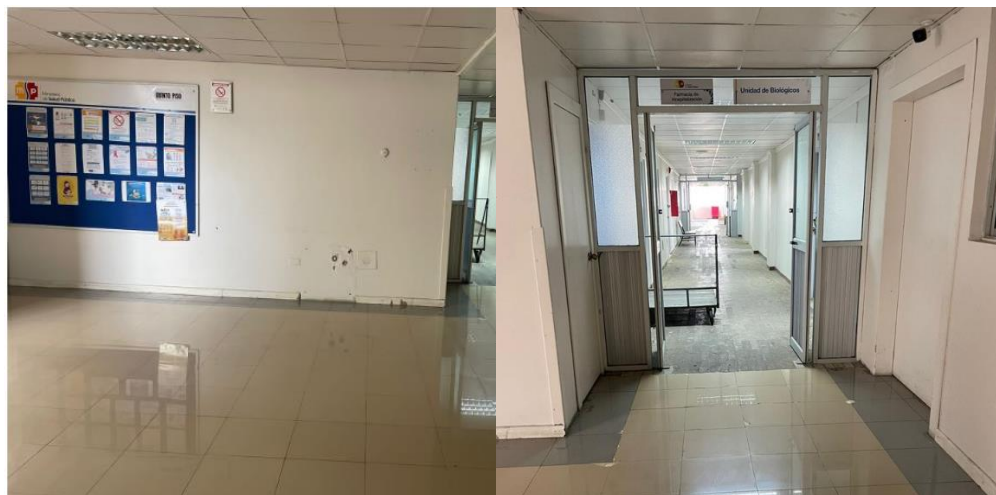
Figura 2.4 Cielo raso en pasillo
