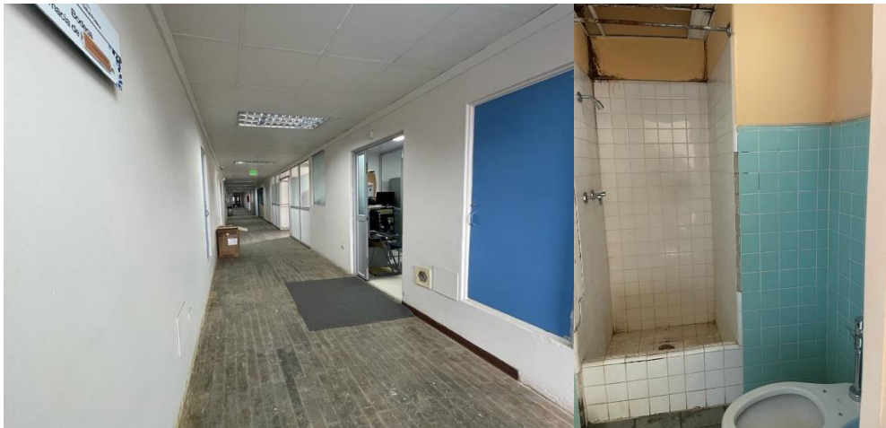
Figura 2.7: Paredes del pasillo y baño de habitaciones
