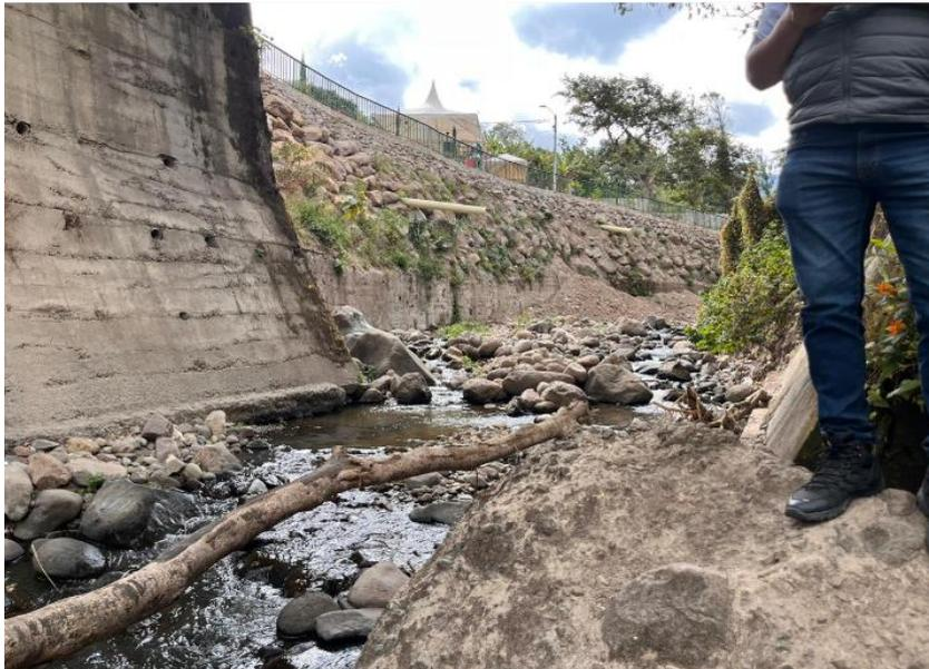
*Ilustración 9 Socavación*
