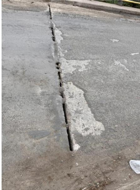
*Ilustración 6 Junta de Dilatación*
