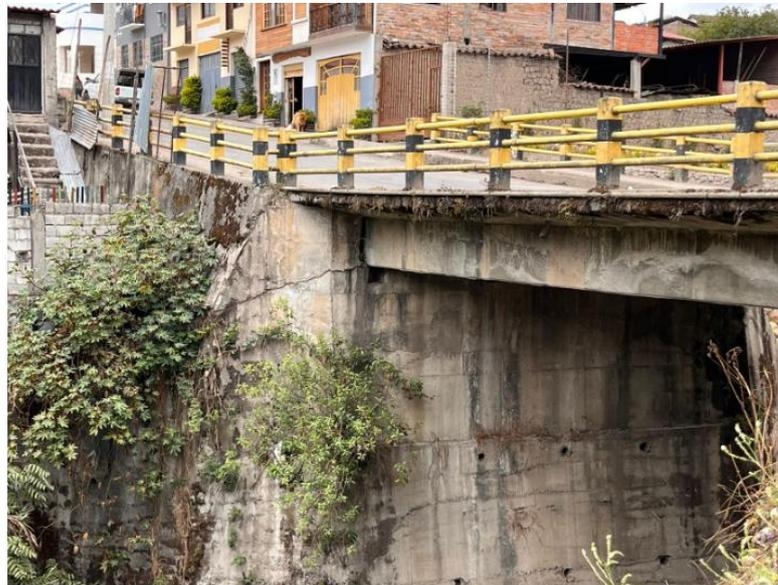
*Ilustración 7 Agrietamiento*
