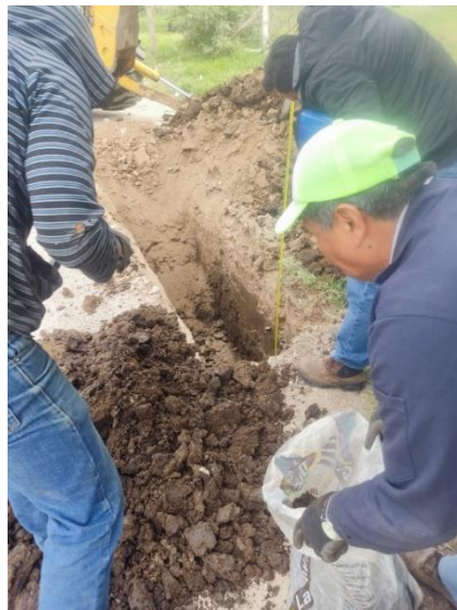
Figura 20: Calicata 1 de la vía Tañiloma-Sanfrancisco Fuente: Elaboracion Propia
