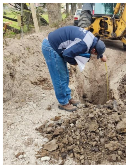
Figura 17: Calicata de la Via Santa Lucrecia Fuente: Elaboración Propia
