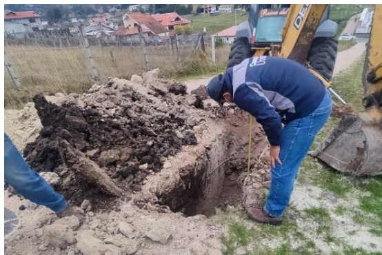
Figura 19: Calicata de la Vía Frente al Cementerio Fuente: Elaboración Propia
