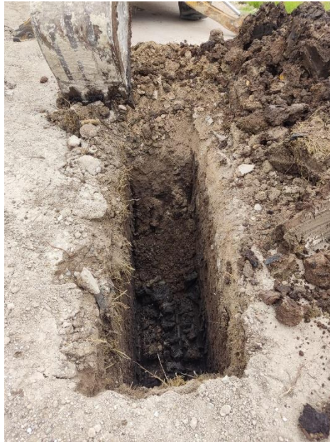
Figura 18: Calicata de la Via Tres de Mayo Fuente: Elaboración Propia
