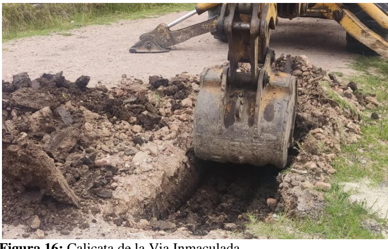
Figura 16: Calicata de la Via Inmaculada Fuente: Elaboracion Propia
