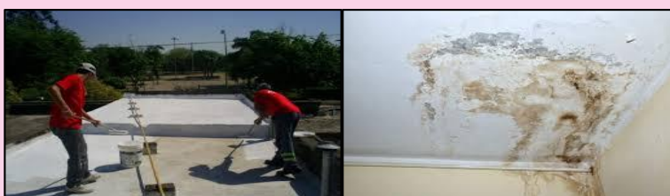
Figura 2. Elaboración de impermeabilizante casero para techos de losa
