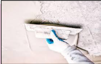
Figura 4. Preparación de techos por filtración
