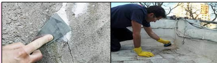
Figura 1. Reparación de grietas en techo de concreto
