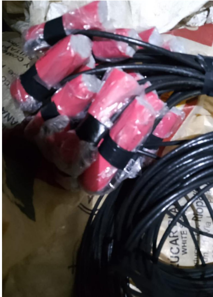
Anexo 4. Preparación del Emulnor 3000 previo a la colocación.
