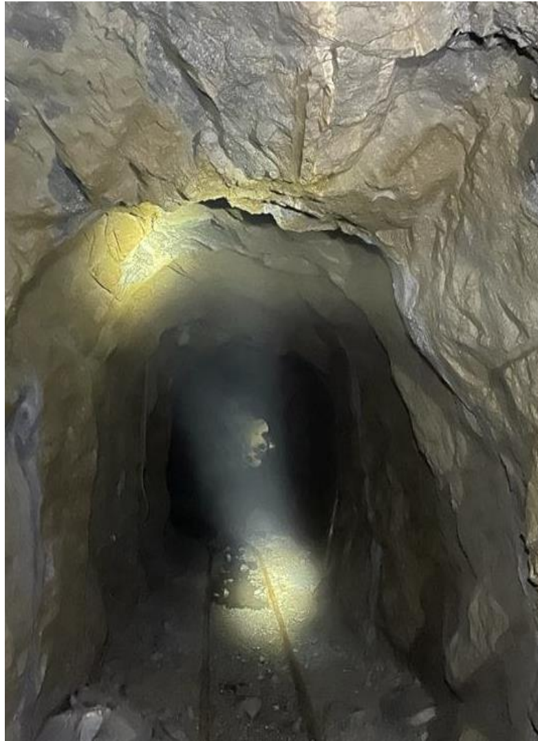
Anexo 6. Frente de explotación luego de la voladura.
